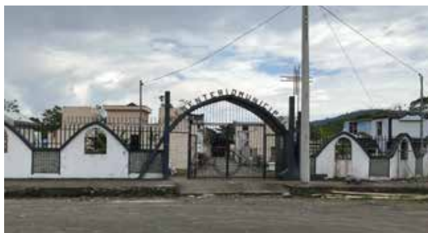
Cerramiento estado actual
