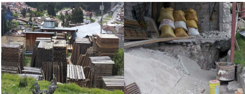
Anexo 2 Maderera afectada por el deslizamiento
