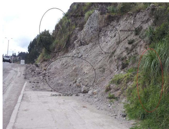
Imagen 8 Geología Local- Desprendimiento de material
