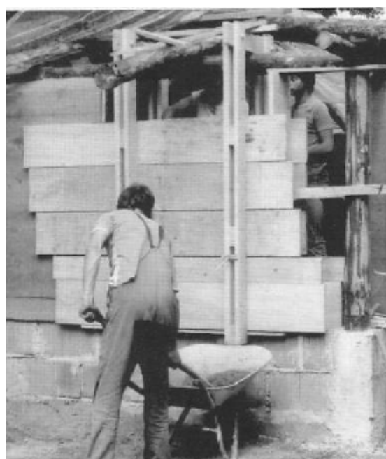
IMG-1.36 Encofrados para paneles de barro apisonado
