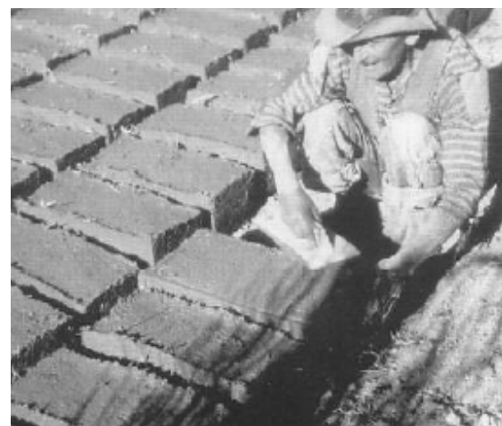
IMG-1.26 Elaboración de adobes en el Ecuador
