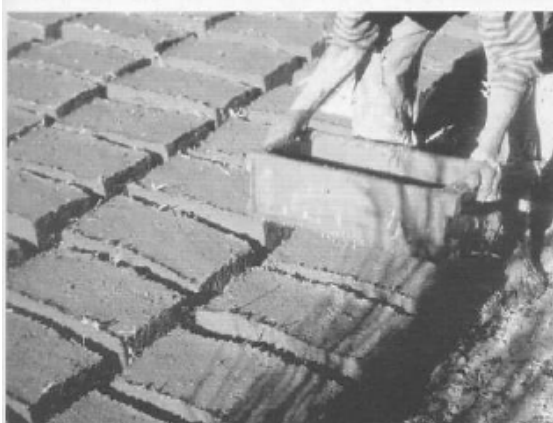
IMG-1.27 Elaboración de adobes en el Ecuador
