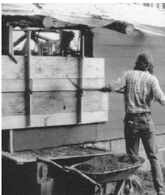
IMG-1.35 Encofrados para paneles de barro apisonado
