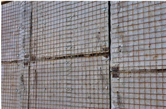
IMG-1.11 Mampostería enchapada con malla de acero
