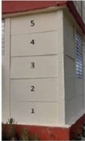
IMG-3.15 Panel colocado en Sistema Sandino
