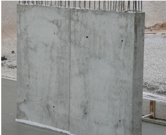
IMG-1.10 Muro portante de hormigón armado
