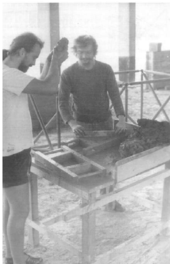
IMG-1.28 Elaboración de adobes sobre una mesa de trabajo
