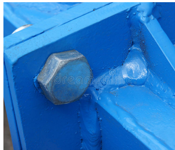
IMG-2.16 Pernos y soldaduras en una junta
