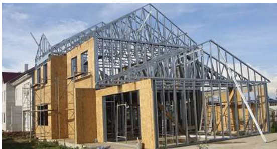
IMG-1.12 Muros portantes livianos de acero (Steel Framing)
