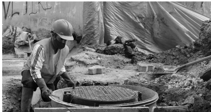
Figura 03 Colocación de alcantarillado público en Quito
