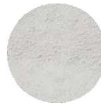
Enlucido de cemento
