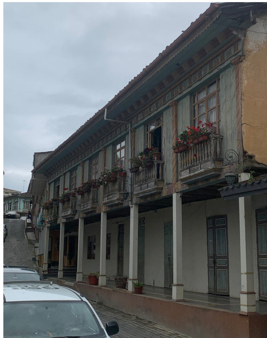
Figura 3.2.3.4 Edificación patrimonial de bahareque y madera en Zaruma
