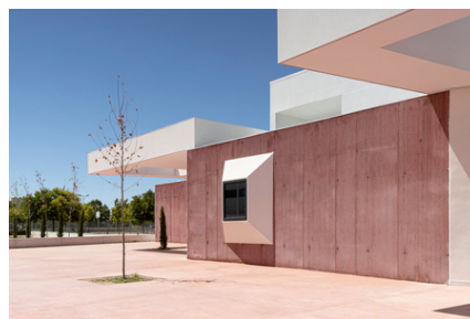
Figura 2.3.12 CEIP Imaginalia / Diaz Romero Arquitectos
