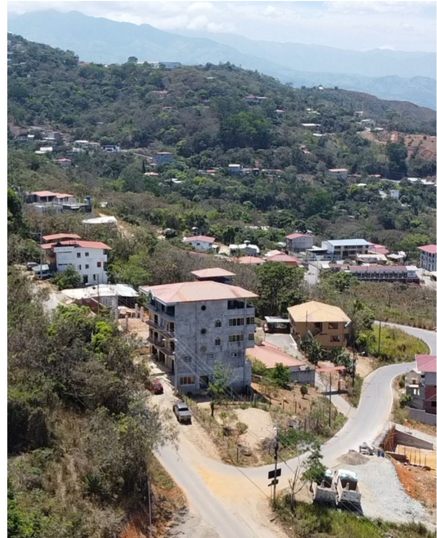
Figura 3.3.4.3 Tipologías de vivienda alrededor del predio (V_01)
