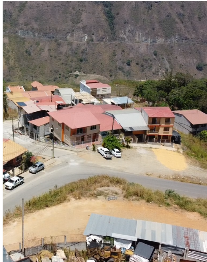
Figura 3.3.4.5 Tipologías de vivienda alrededor del predio (V_03)
