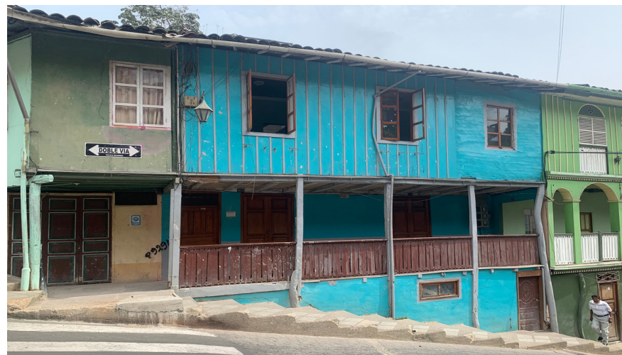
Figura 3.2.3.5 Edificaciones patrimoniales en Calle Colon
