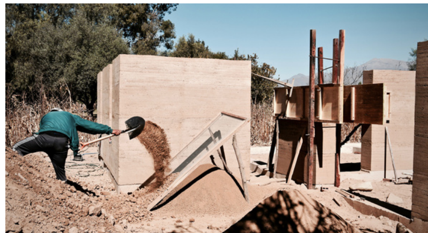
Figura 1.3.2.5 Preparación de tierra para la elaboración de paredes de tapial
