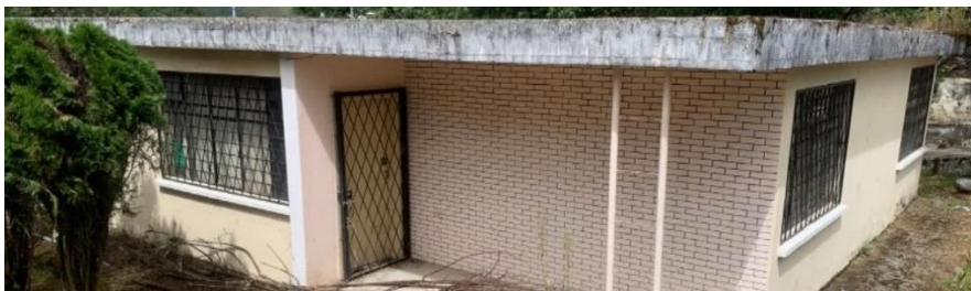
Figura 3.39: Estado actual de las oficinas EMMAICJ EP de Girón. Fuente: Propia
