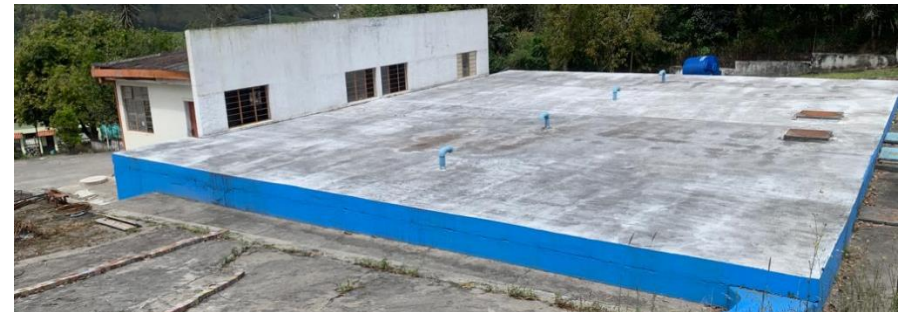
Figura 3.41: Estado actual de los tanques de reserva de agua. Fuente: Propia
