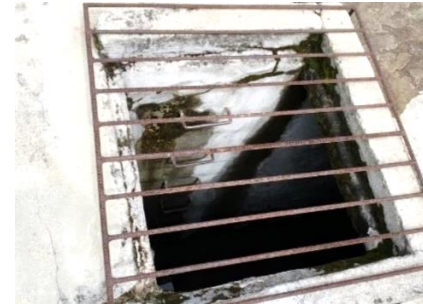
Figura 3.30: Estado actual ingreso al tanque subterráneo. Fuente: Propia
