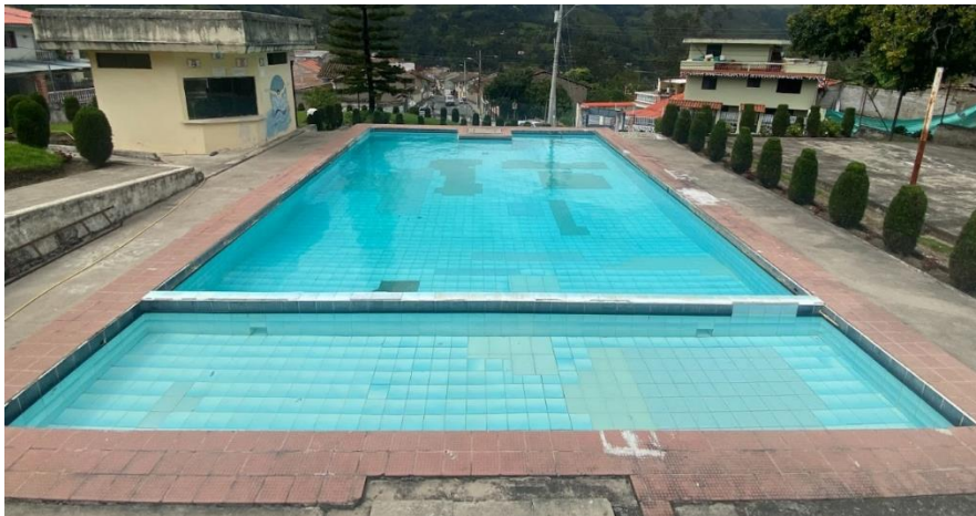
Figura 3.27: Estado actual de la piscina municipal de Girón Fuente: Propia
