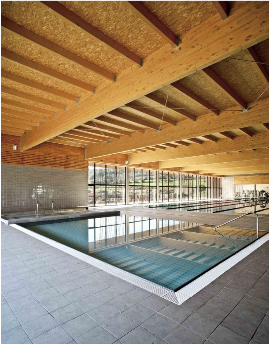
Figura 4.10: Vista interior de la Piscina Municipal de Sentmenat. Fuente: Sagredo, R. (2023).
