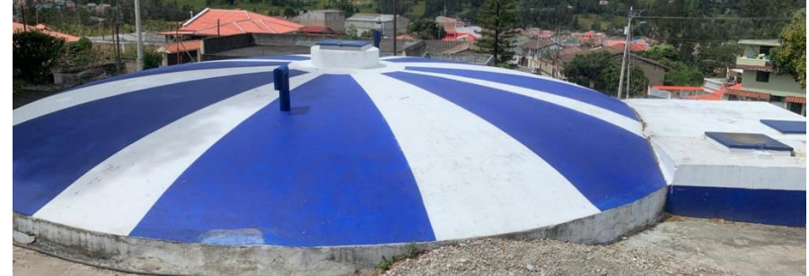
Figura 3.40: Estado actual del tanque circular. Fuente: Propia
