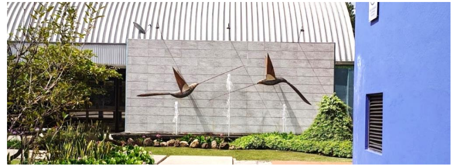
Figura 4.18: Vista exterior de la Piscina del CREDU. Fuente: Propia
