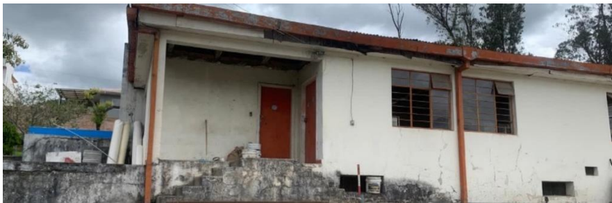
Figura 3.38: Estado actual de las bodegas. Fuente: Propia
