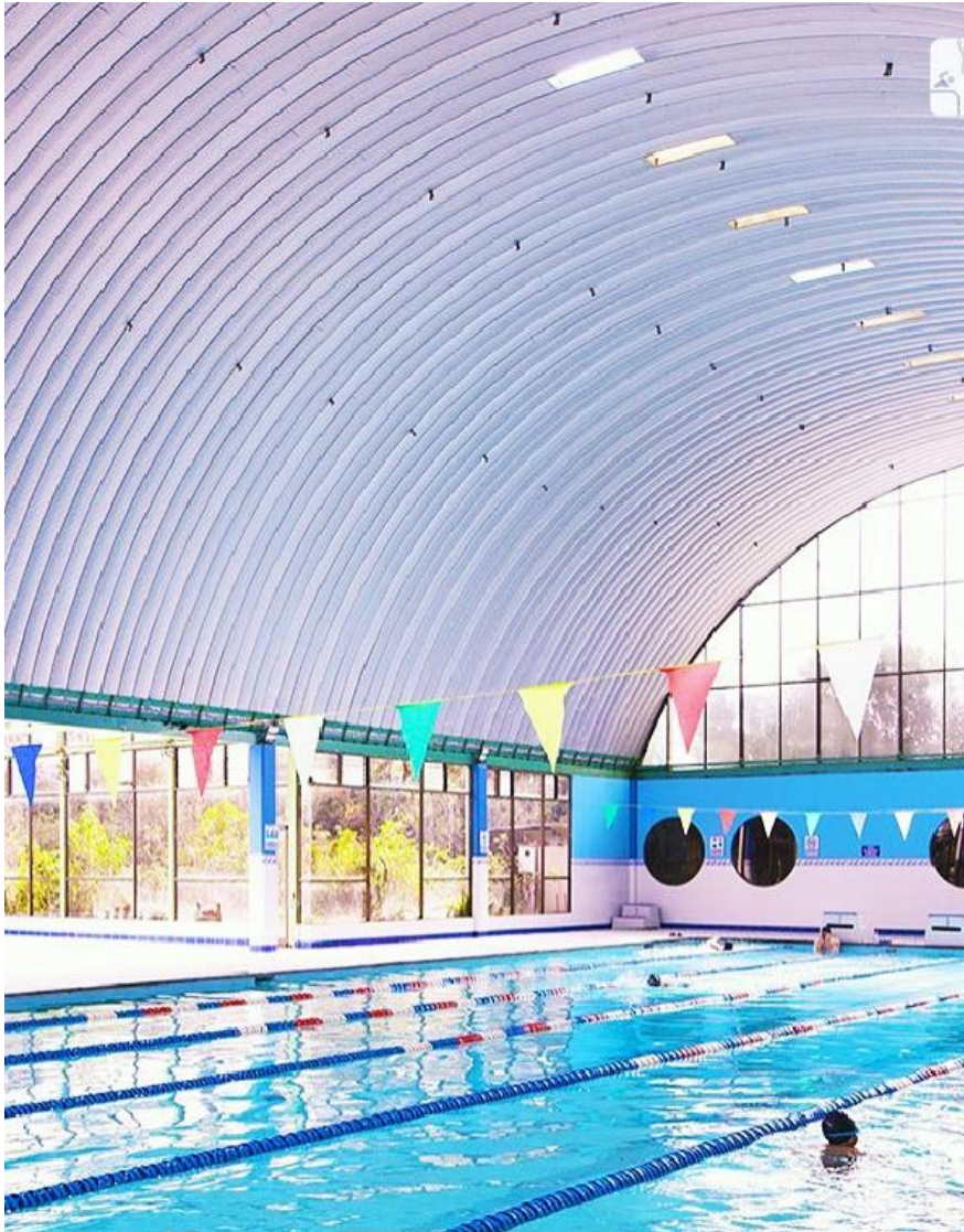
Figura 4.21: Vista interior de la Piscina del CREU Fuente: Propia
