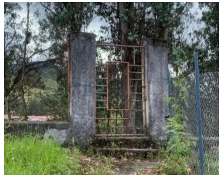
Figura 3.37: Estado actual del acceso peatonal al lote de las oficinas EMMAICJ EP. Fuente: Propia
