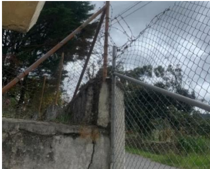
Figura 3.36: Estado actual del cerramiento. Fuente: Propia
