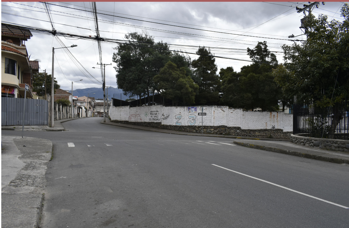
Fig. 91. Intersección de las calles Padre Julio Matovelle y Lorenzo Piedra: Estado actual.
