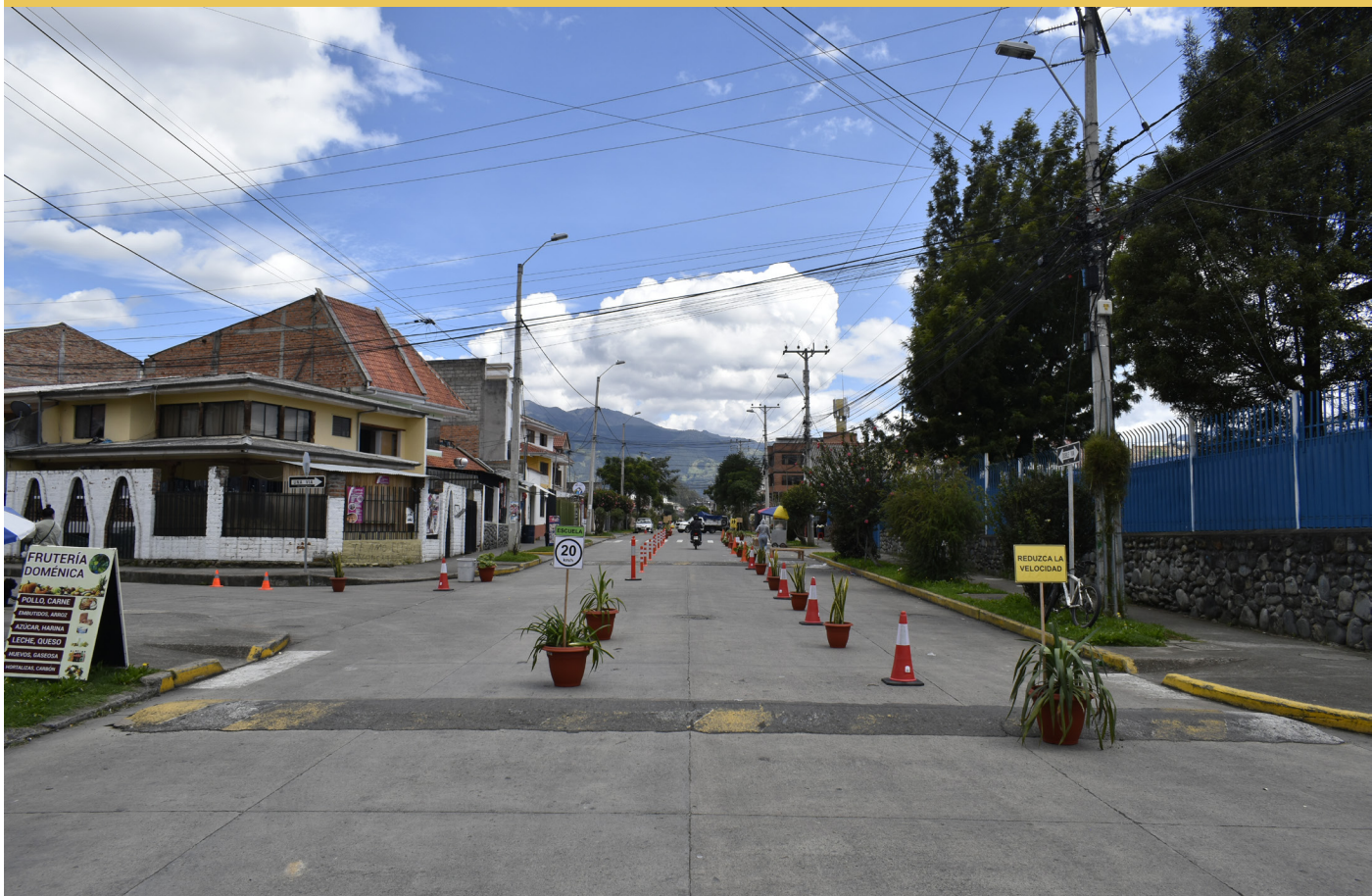
Fig. 62. Entorno de la Escuela Nicolás Sojos durante la intervención.
