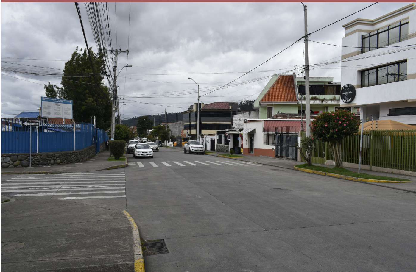
Fig. 104. Intersección de la Av. Cristóbal Colón y la calle Miguel Hernández: Estado actual.
