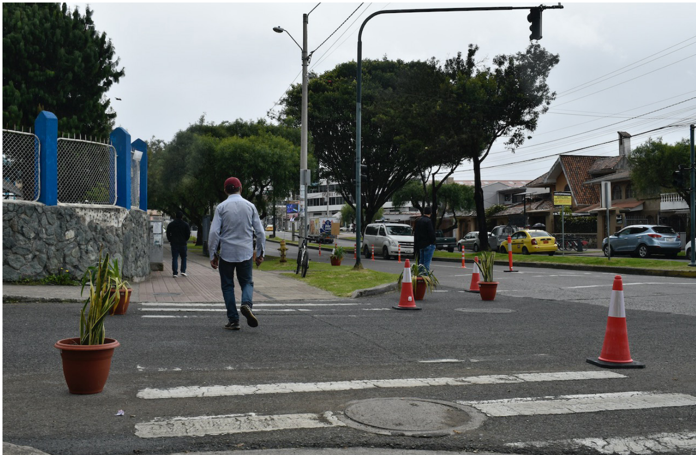
Fig. 56. Ensanchamientos de vereda en la calle Lorenzo Piedra durante la intervención.
