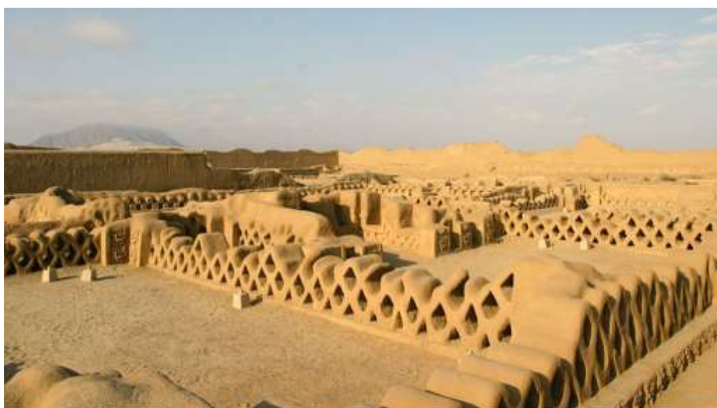
Figura 4. Ciudad de Chan Chan, Perú. Construida de adobe (Jurado & Vergara, 2019).
