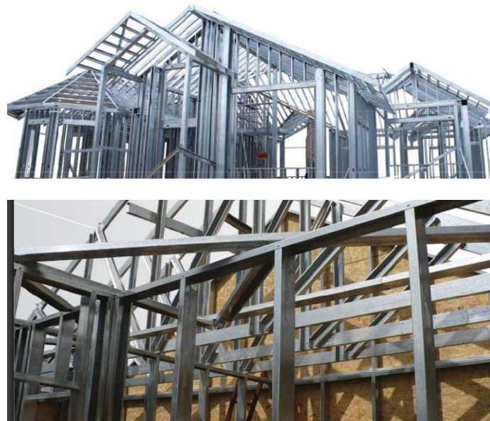
IMAGEN N° 3 SISTEMA CONSTRUCTIVO ESTRUCTURAL LIVIANO “SEL”.
