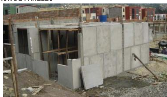
IMAGEN N° 7. COLOCACIÓN DE PANELES
