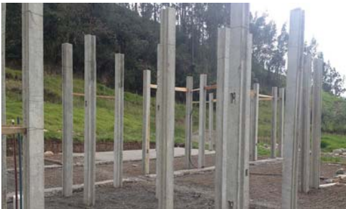
IMAGEN N° 4 COLUMNAS DE HORMIGÓN PRETENSADO
