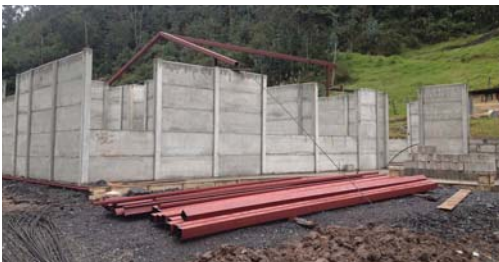
IMAGEN N° 5 PANELES DE HORMIGÓN PRETENSADO
