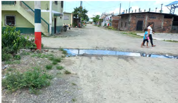
Figura 3.27: Aguas estancadas que causan olores desagradables. Fuente: Propia.
