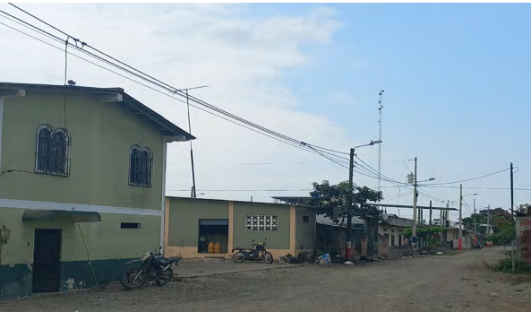
Figura 3.17: Visual interna 2. Fuente: Propia.
