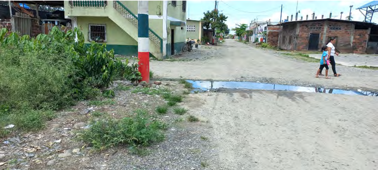
Figura 4.28: Estado actual de las vías del recinto 6 de Julio, Naranjal. Fuente: Propia.
