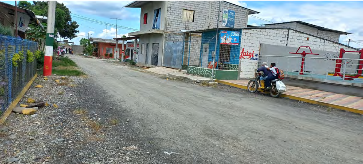
Figura 4.29: Estado actual de las vías del recinto 6 de Julio, Naranjal. Fuente: Propia.
