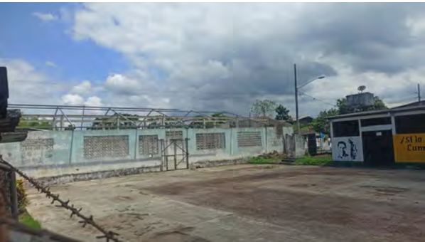
Figura 3.64: Casa comunal. Fuente: Propia.
