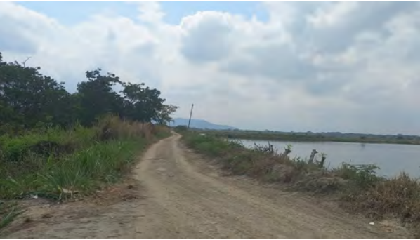
Figura 3.34: Vía de conexión. Fuente: Propia.
