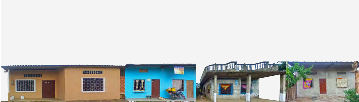
Figura 3.48: Tramo 04, correspondiente a la calle San Martín, entre las calles 6 de Julio y 1 de Mayo. Fuente y elaboración: Propia.
