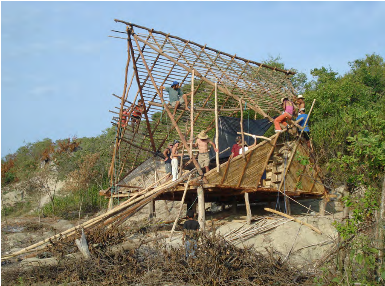
Figura 2.22: Construcción escuela Nueva Esperanza. Fuente: Plataforma Arquitectura
