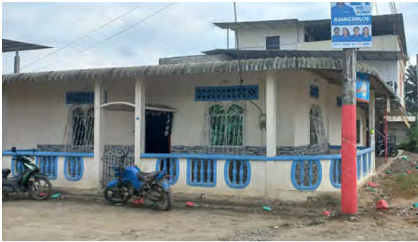
Figura 3.25: Edificaciones de un piso. Fuente: Propia.
