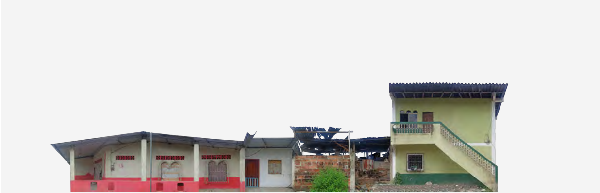
Figura 3.50: Tramo 06, correspondiente a la calle 1 de Mayo, entre las calles 24 de Septiembre y 10 de Agosto. Fuente y elaboración: Propia.
