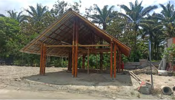
Figura 3.39: Construcción existente en bambú. Fuente: Propia.
