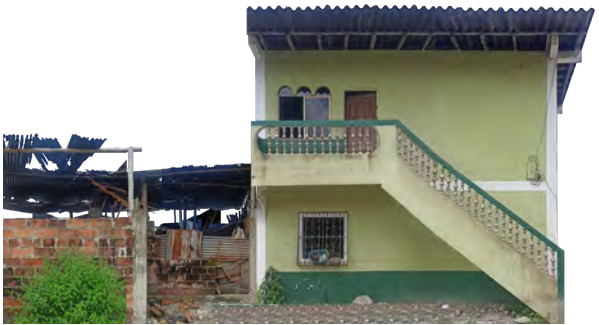
Figura 3.26: Edificación de dos pisos. Fuente: Propia.
