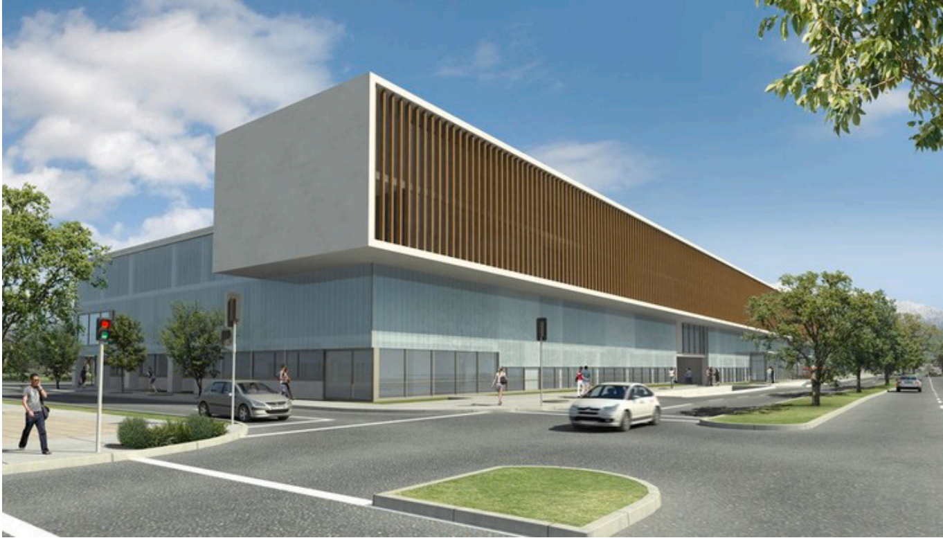
Figura 3.137: Vista a la altura del espectador del Hospital Dra. Eloísa Díaz. Fuente: https://www.archdaily.cl/cl/02-21651/nuevos-hospitales-para-santiago-la-florida-y-maipu-murtinho-raby
