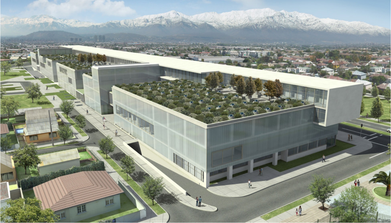
Figura 3.136: Vista aérea del Hospital Dra. Eloísa Díaz. Fuente: https://www.plataformaurbana.cl/archive/2009/06/23/concesionan-nuevos-hospitales-en-la-florida-y-maipu/ .
