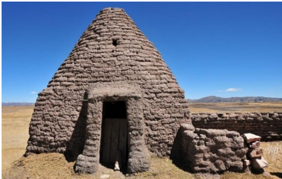
Figura 3. Putuco. Vivienda tradicional del altiplano de Puno elaborado a base de bloques de barro y pasto. (Andina, 2015).
