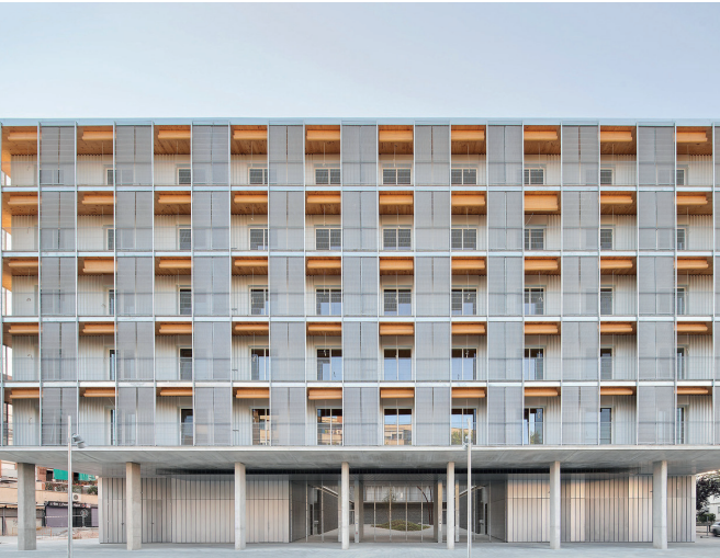
Imágen 66: Visual exterior Proyecto Vivienda social en Cornellà Fuente: Plataforma Arquitectura, 2022
