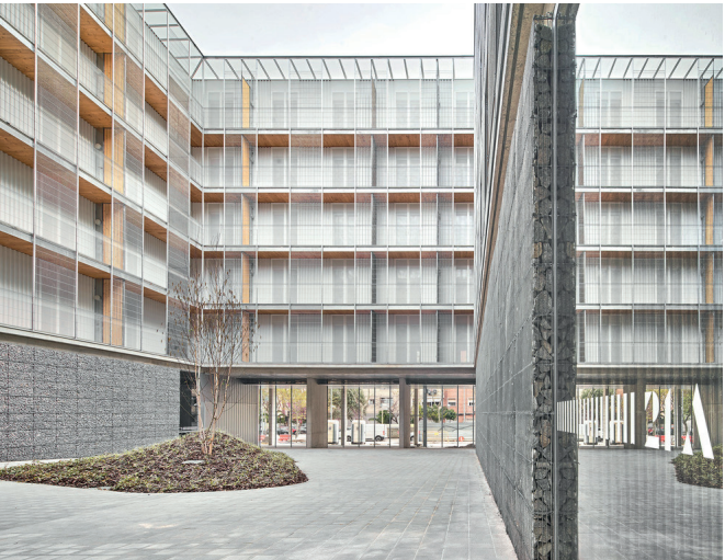
Imágen 69: Visual exterior Proyecto Vivienda social en Cornellà Fuente: Plataforma Arquitectura, 2022
