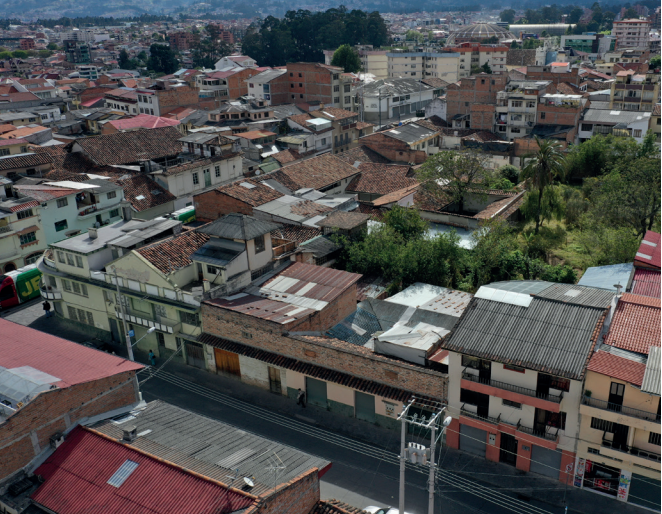
Imagen 117: Fotografía aérea a Lote con acceso desde la Av. Miguel Heredia Fuente: Autores, 2022
