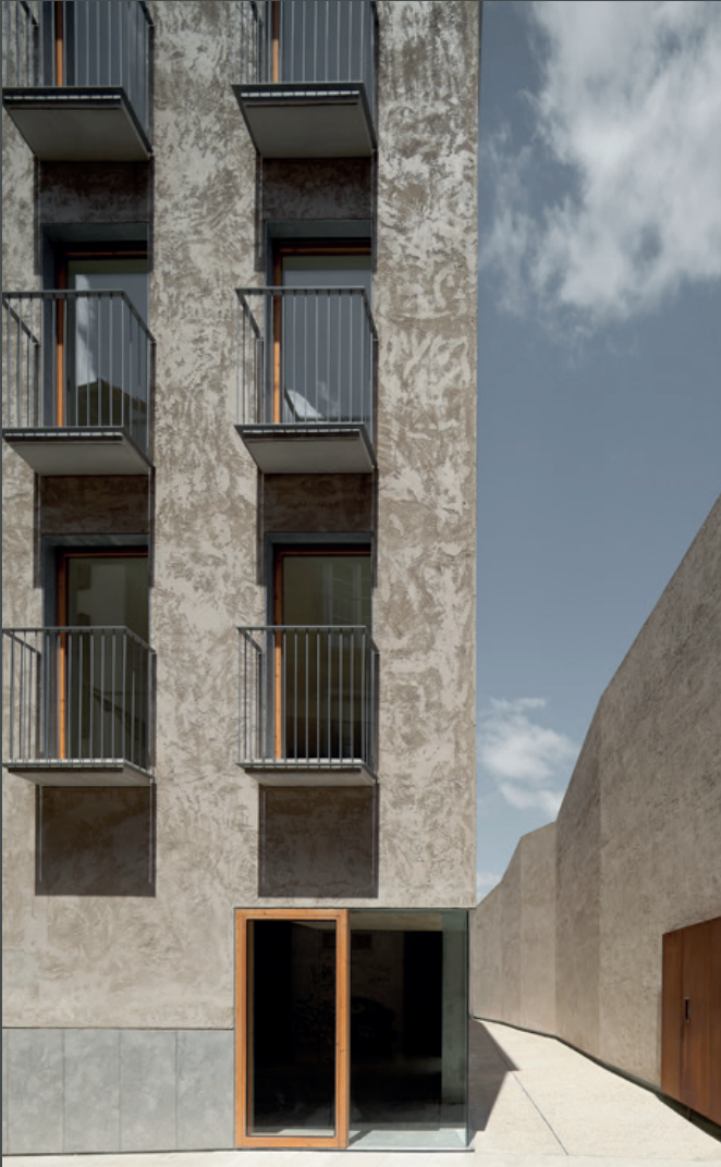
Imágen 101: Fachada frontal, edificio de viviendas para realojos Pamplona Fuente: Plataforma Arquitectura, 2015.
