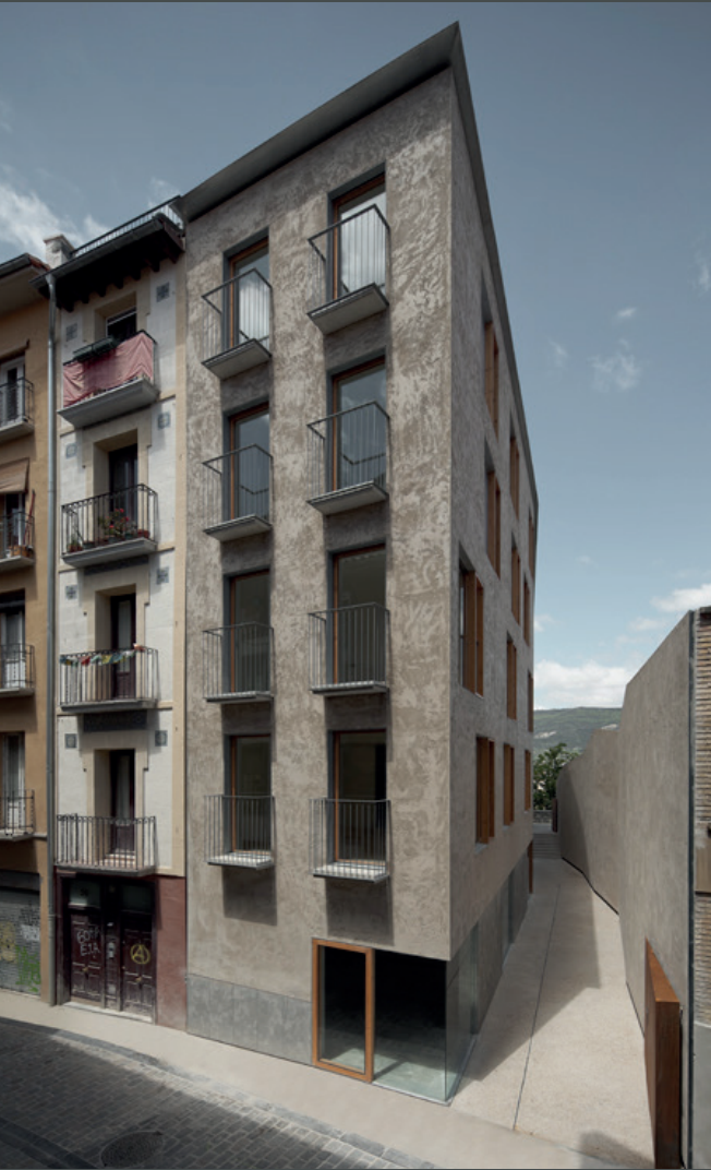
Imágen 105: Fachada frontal, edificio de viviendas para realojos Pamplona Fuente: Plataforma Arquitectura, 2015.
