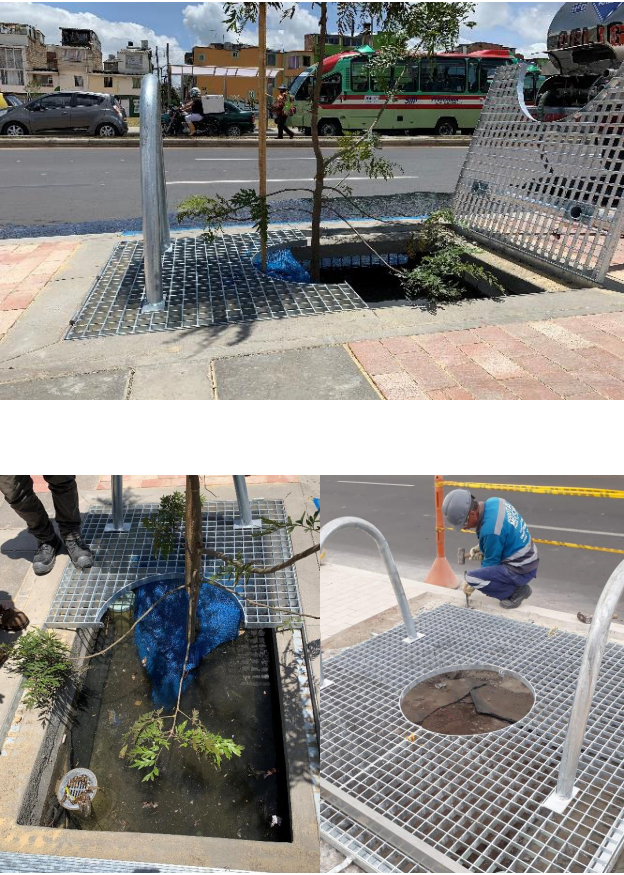
Figura 2.27 Etapa de construcción y pruebas Suds.
