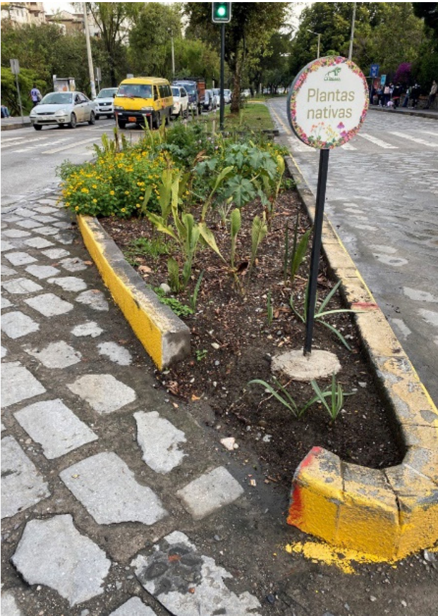
Figura 2.40 Sección de un alcorque inundable.
