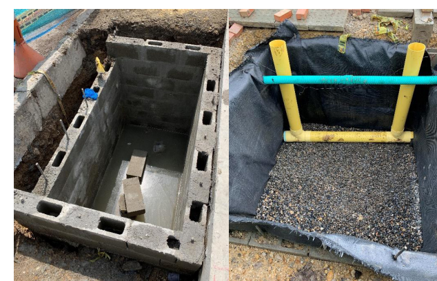
Figura 2.30 Estructura y capa de filtración de Suds.
