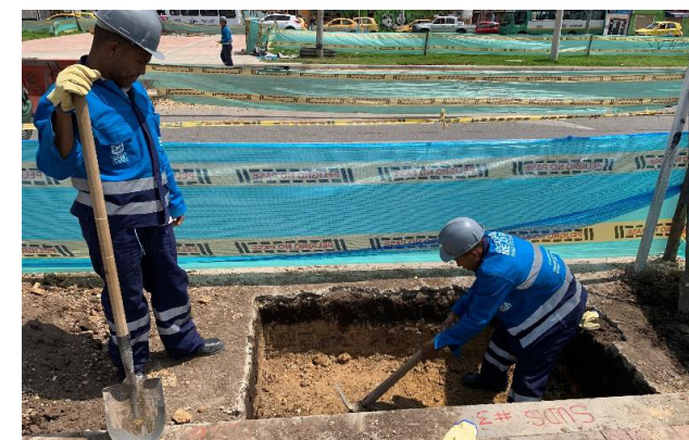
Figura 2.29 Excavación para la colocación.
