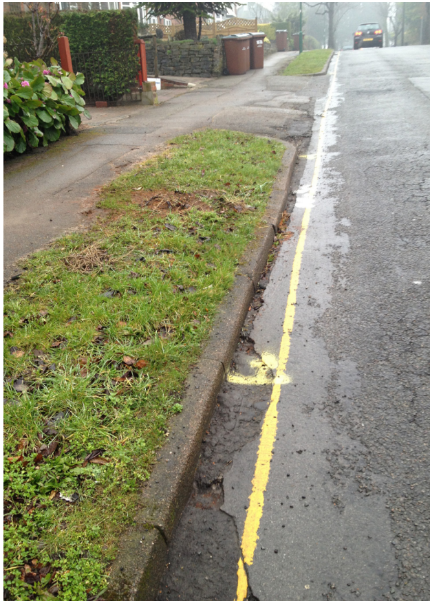
Figura 2.20 Nottingham, antes de la intervención.
