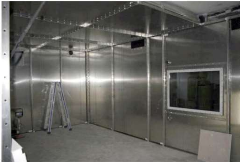
Ilustración 47: Blindaje en la sala de RM (Jaula de Faraday).
