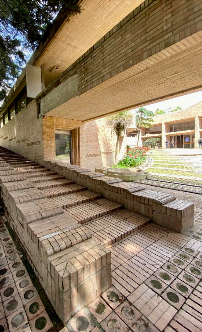
112 Rampa-escalera de acceso hacia auditorios (2022). Fotografía © Claudia Guerrero.
