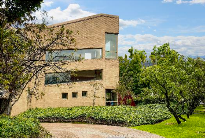
115 Fachada occidental. Torre, acceso a parqueo (2022) Fotografía © Claudia Guerrero.
