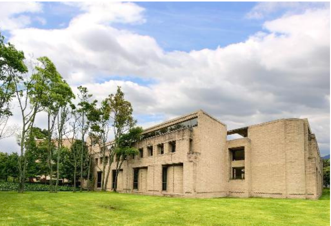
116 Fachada suroccidental. Aularios y oficinas (2022) Fotografía © Claudia Guerrero.
