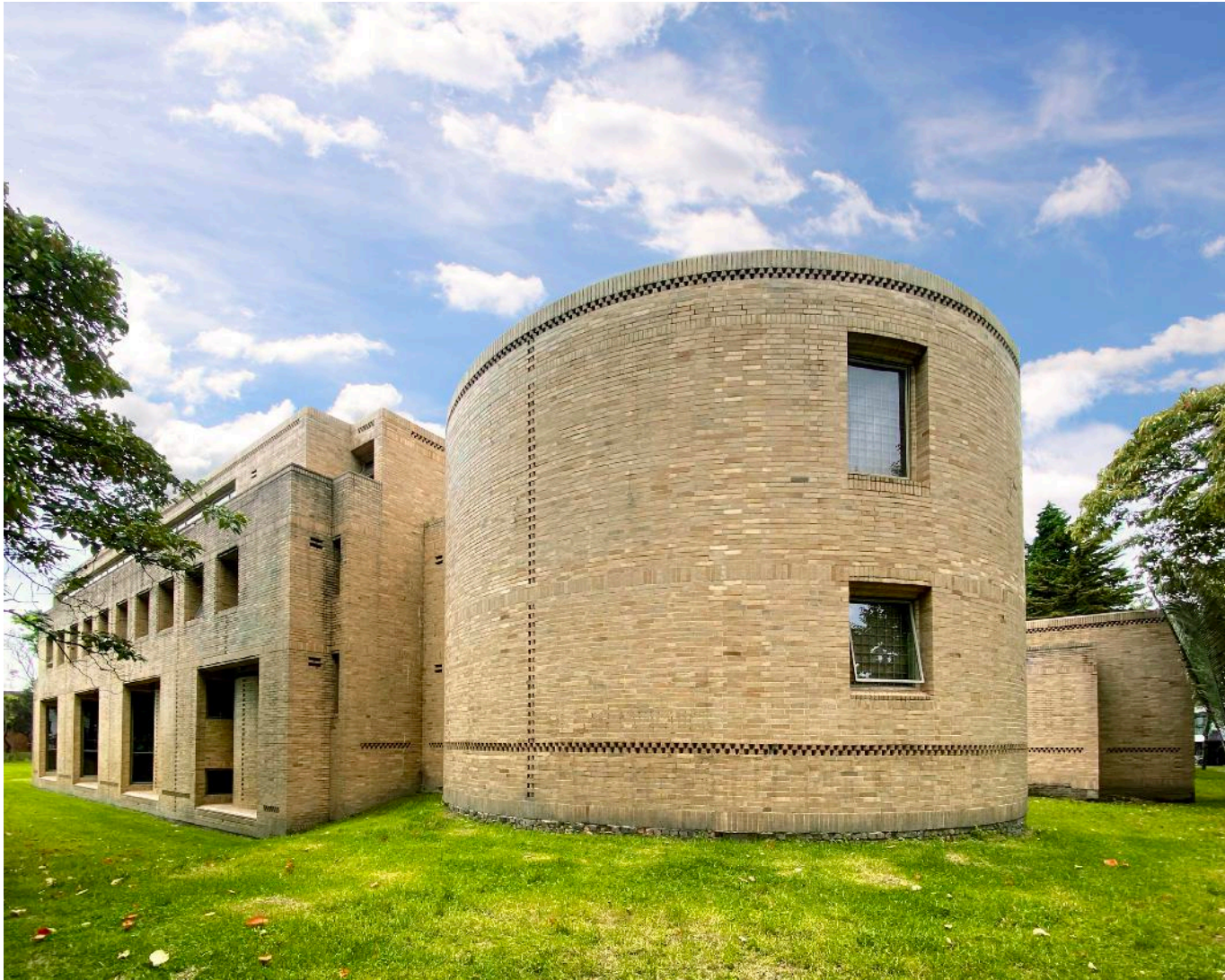
107 Edificio de Posgrados de Ciencias Humanas. Fachada suroriental. Fotografía Claudia Guerrero. Marzo del 2022.
