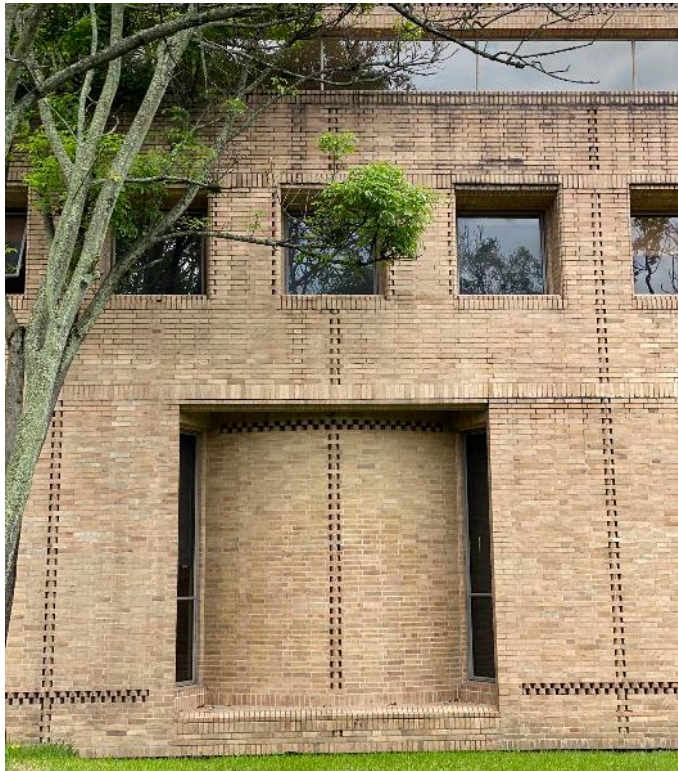
202 Aulario: fachada suroeste (2022). Fotografía © Claudia Guerrero.
