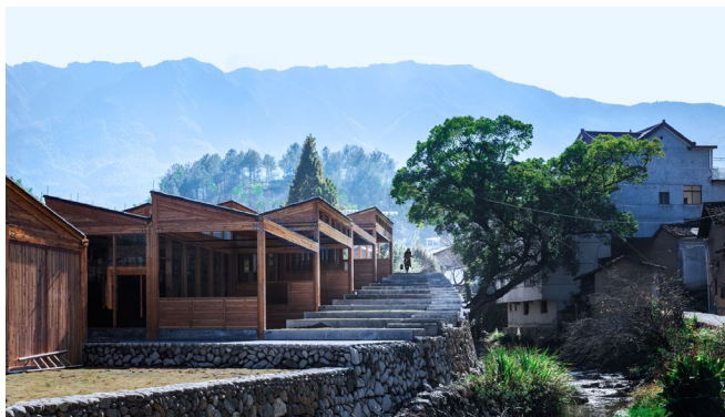
Figura 83 Vista exterior, Fábrica de Tofu. Fuente: Plataforma arquitectura,2022.
