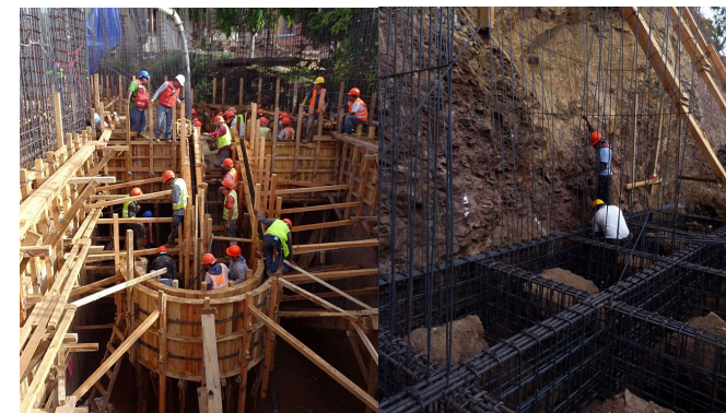
Figura 72 Encofrado de gradas, Armado de cimentación. Fuente: BONARQ Espacio & Diseño.
