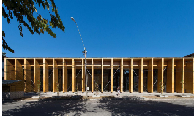
Figura 54 Fachada principal, Centro cultural Constitución. Fuente: Plataforma arquitectura.
