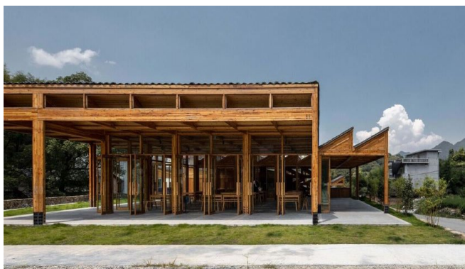
Figura 85 Vista exterior, Fábrica de Tofu. Fuente: Designverse,2021.
