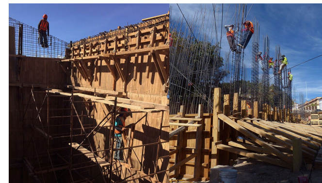
Figura 73 Encofrado, armado de columnas y muros. Fuente: BONARQ Espacio & Diseño.
