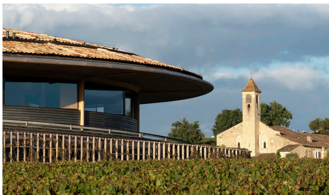
Figura 50 Fotografía exterior, Bodega Le Dôme Fuente: Plataforma arquitectura.
