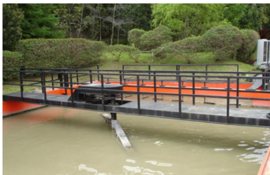
Fotografía 93 Desarenadores cuadrado de flujo horizontal
