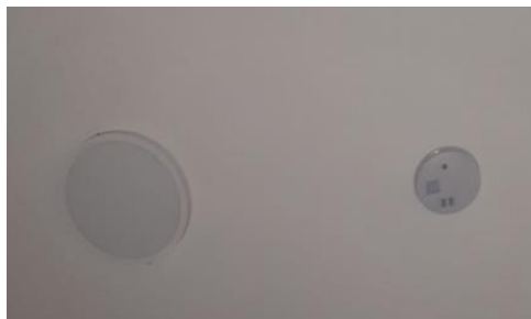
Fotografía 73 Foco en bodega Autores: Andrea Auquilla y Bibeca Erazo Fuente: Propia Fecha: 03 de mayo de 2022
