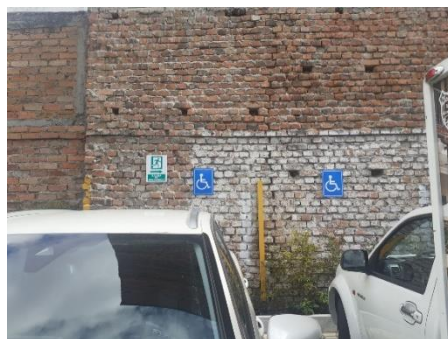
Fotografía 88 Señaléticas ubicadas en el parqueadero Autores: Andrea Auquilla y Bibeca Erazo Fuente: Propia Fecha: 03 de mayo de 2022
