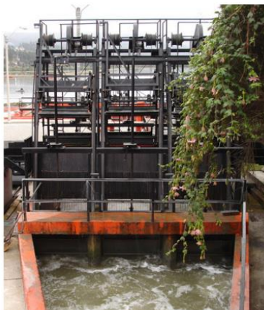
Fotografía 92 Cribas mecánicas autolimpiantes
