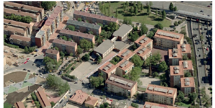
Fotografía 8: Vista aérea del barrio
