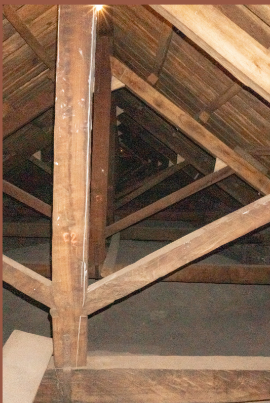
Foto. 102. Estructura de la cubierta de la nave central en donde se aprecian las distintas vigas y el entablado. Por autoras.
