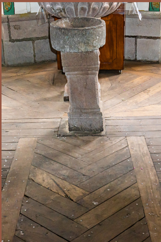
Foto. 96. Entablado original en la zona del baptisterio. Se aprecian las duelas colocadas a 45 grados. Por autoras.
