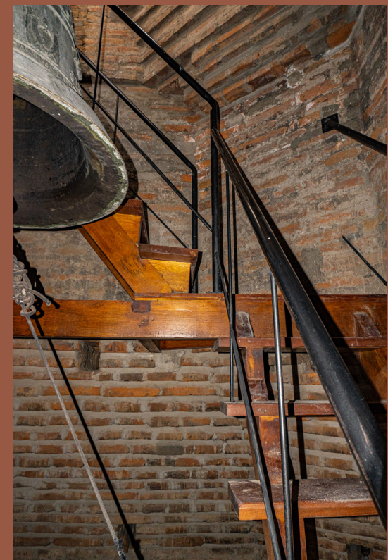
Foto. 107. Escalera de acceso al mirador de la torre desde el primer piso. Por autoras.
