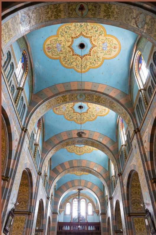
Foto. 90. Bóvedas vaídas del templo, vistas desde el altar mayor. Por autoras.
