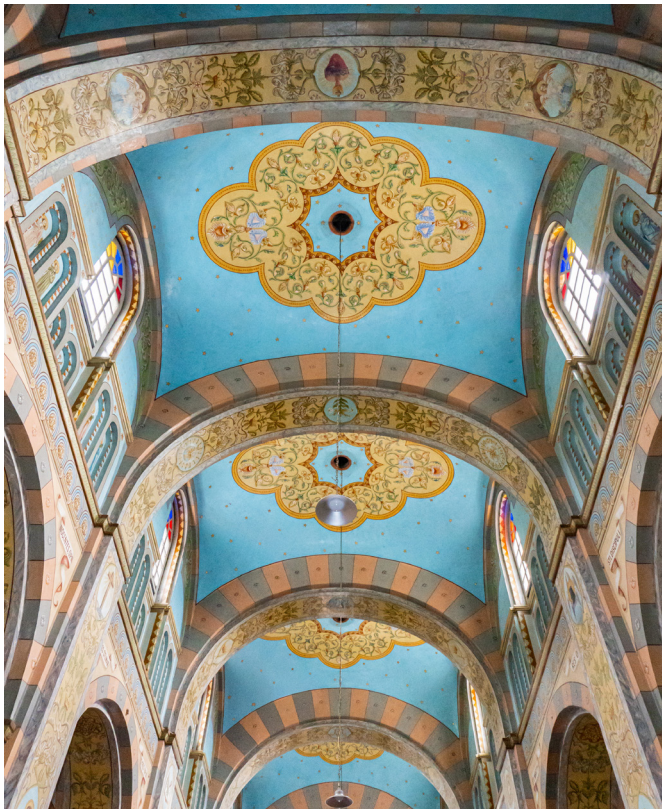
Fotografía 43. Bóveda vaída de la iglesia de San Roque de Quito, que se encuentra en la nave central.
