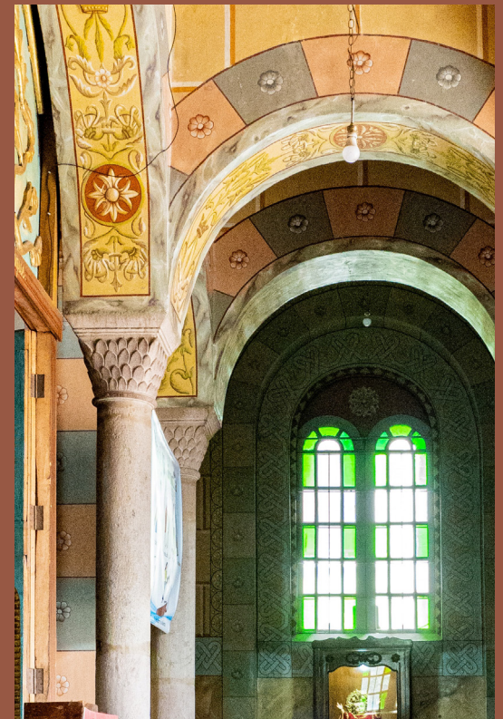
Foto. 118. Detalle de la zona del nartex en donde se observan los capiteles bizantinos de las columnas que soportan el coro. Por autoras.
