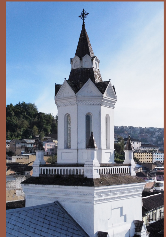
Foto. 109. Exterior de la torre del templo de San Roque, en donde se aprecia el enlucido de la misma, los tejuelos, y las torrecillas. Por parroquia de San Roque.
