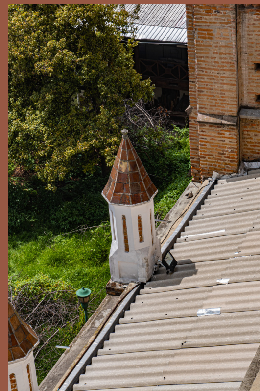
Foto. 104. Cubierta de la nave lateral, en donde se ve las planchas de eternit. Por autoras.
