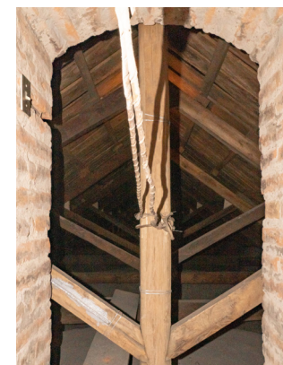
Fotografías 44,45,46. Estructura de las bóvedas vaídas de la iglesia de San Roque de Quito, vista desde la torre del campanario.
