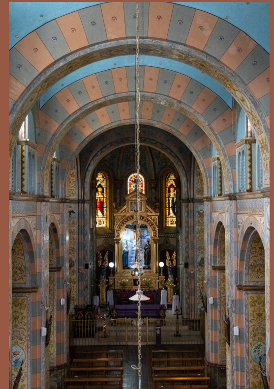
Foto. 89. Sistema estructural de arcos de medio punto vistos desde el coro. Por autoras.
