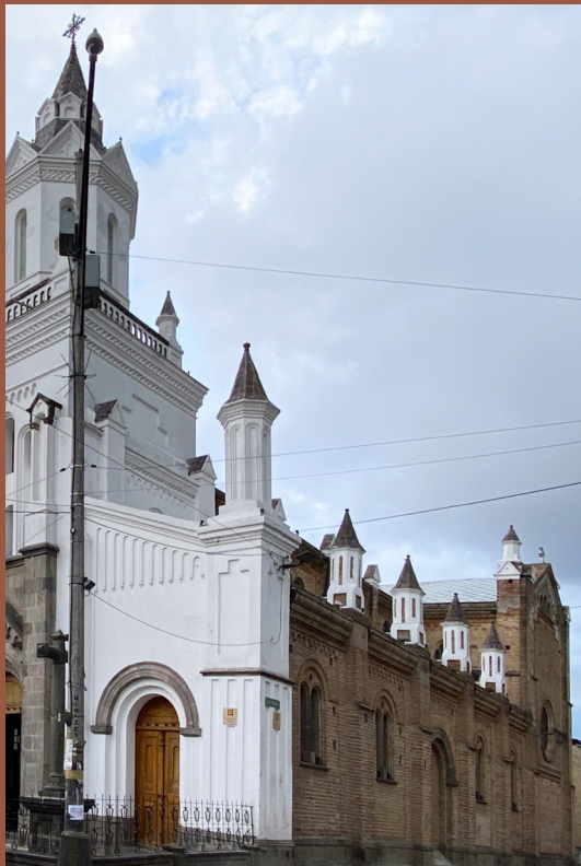
Foto. 87. Muro portante de la iglesia de San Roque visto desde la calle Chimborazo. Por Parroquia de San Roque.
