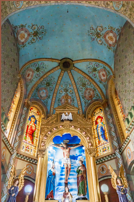
Fotografía 124. Zona del presbiterio, se observa tanto las paredes como las bóvedas y nervaduras. Por autoras.
