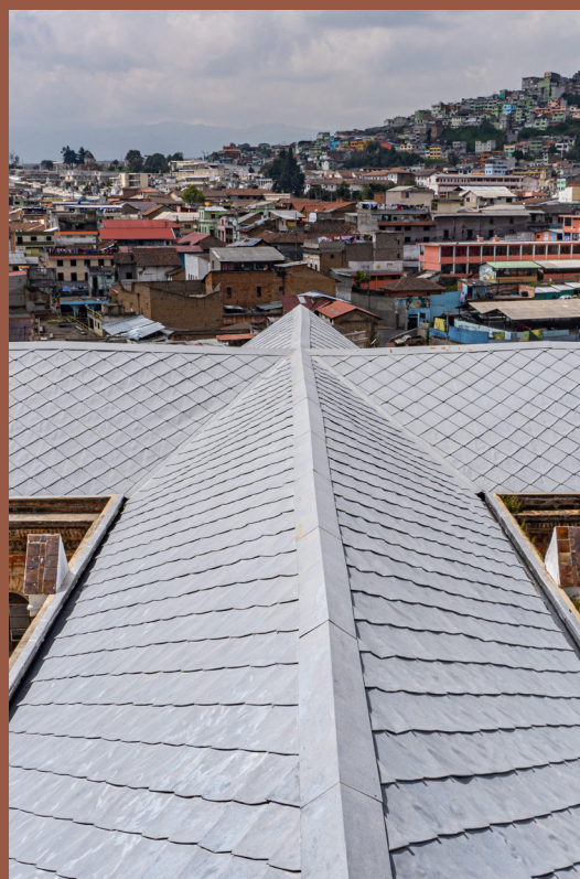
Foto. 103. Cubierta de la nave central, de crucero y presbiterio desde la torre. Se observan las tejas de tol. Por autoras.
