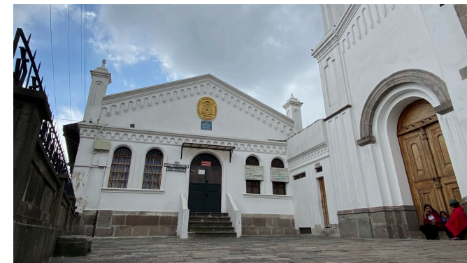
Fotografía 66 y 67. Casa parroquial construida en 1943 en la actualidad.
