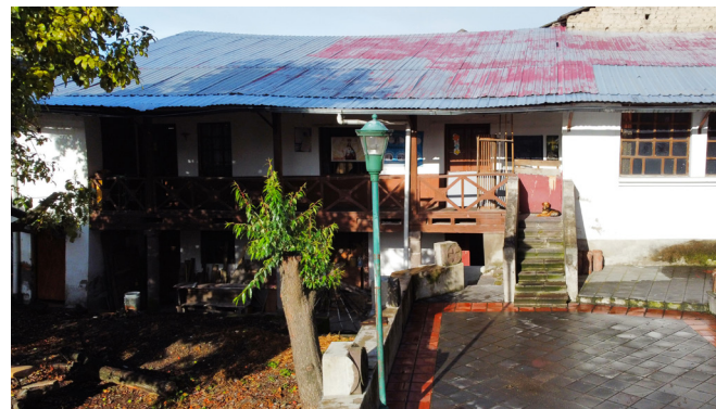
Fotografía 64 y 65. Casa parroquial construida en 1848 en la actualidad.
