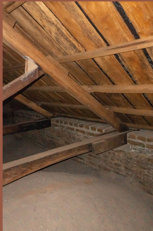
Foto. 91. Interior de las bóvedas. Se puede observar la estructura de la cubierta y de la bóveda de piedra pomez. Por autoras.
