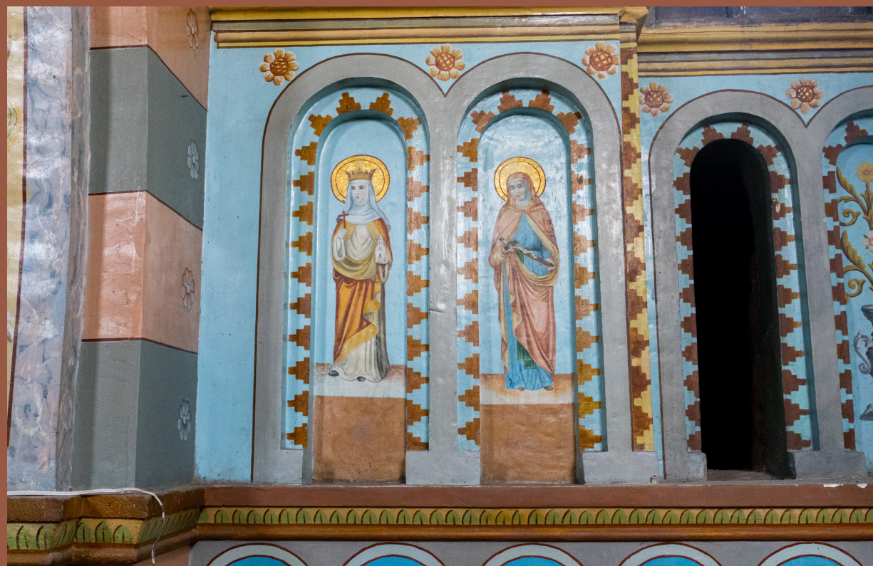
Foto. 128. Detalle de pinturas realizadas sobre los nichos. Por autoras.
