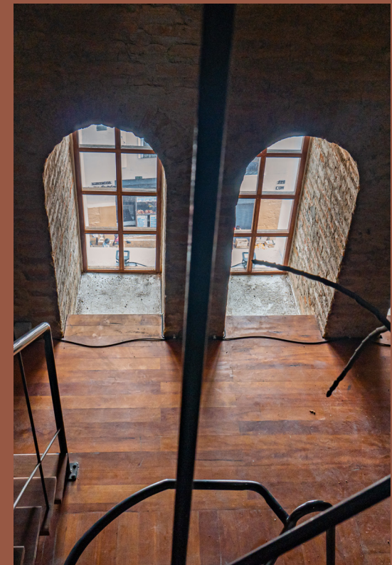
Foto. 98. Piso de madera del primer piso de la torre. Por autoras.
