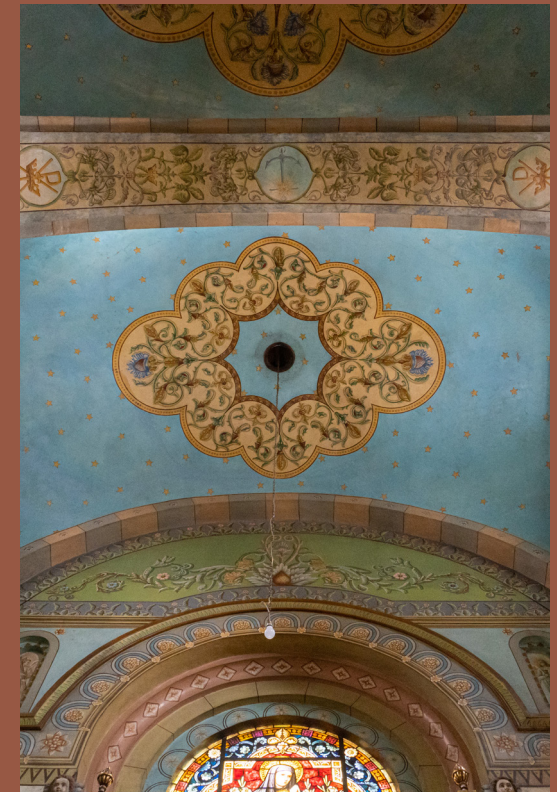
Foto. 112. Interior de la Iglesia de San Roque. Se puede ver el uso de arcos de medio punto para soportar las bóvedas, además de en los vanos de ventanas. Por autoras.
