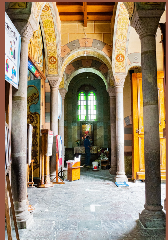
Foto. 86. Columnas de piedra que soportan el entepiso del coro con capitel bizantino. Por autoras.
