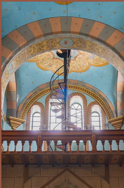
Foto. 106. Escalera helicoidal ubicada en el coro de la iglesia, da acceso al primer piso de la torre. Por autoras.
