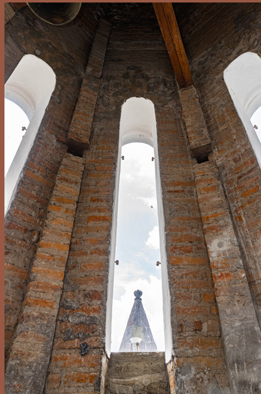
Foto. 108. Interior de la torre del templo de San Roque. Se puede apreciar el ladrillo visto. Por autoras.
