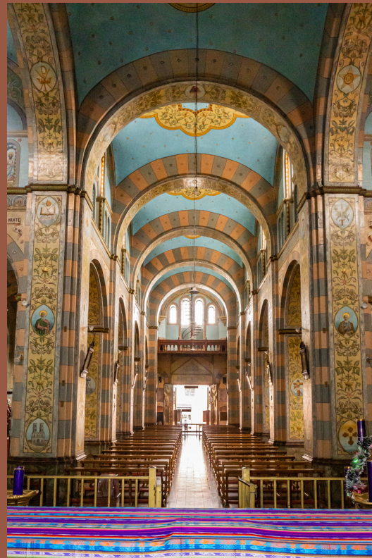
Foto. 88. Sistema estructural de arcos de medio punto vistos desde el altar mayor. Por autoras.
