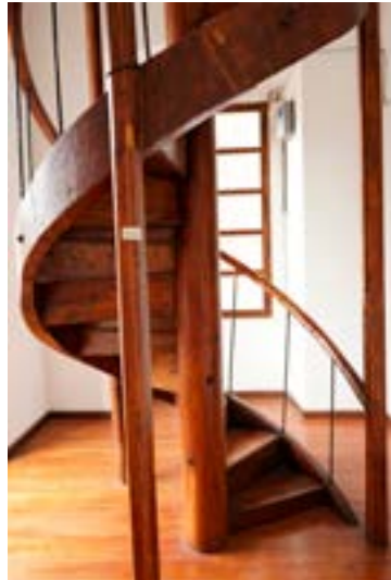
Fig. 100. Escalera circular de madera a terraza.
