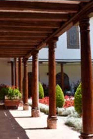
Fig. 104. Columnas entorno a patio.
