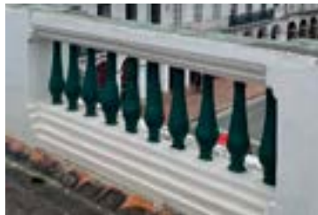
Fig. 101. Balaustrada cerámica en terraza hacia fachada frontal.
