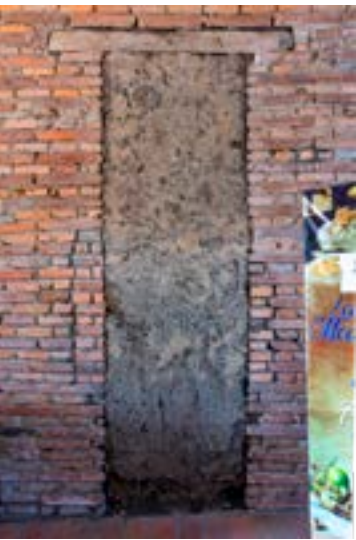
Fig. 88. Muro de ladrillo artesanal en acceso principal desde la calle Benigno Malo.
