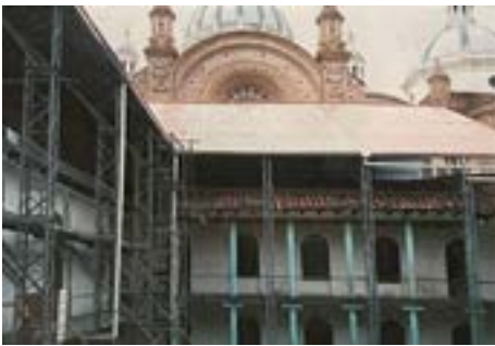
Fig. 52. Cubierta provisional sobre el seminario San Luis. Fuente: Memoria del estado actual de la capilla y el tramo posterior hacia la calle Santa Ana después del incendio ocurrido en el mes de agosto del año 2012 - Arq. Daniel Barrera.
