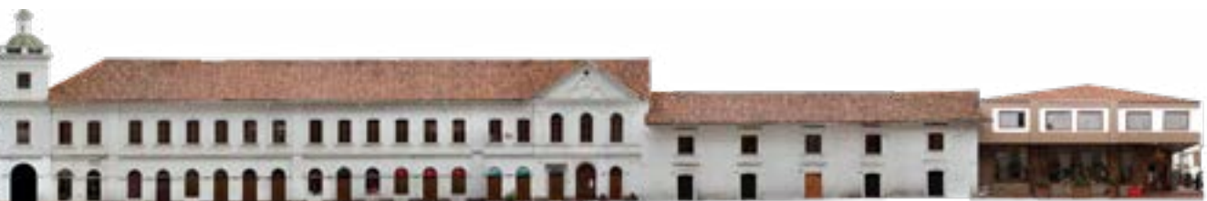
E2_002 FACHADA SIMÓN BOLIVAR - 2022
