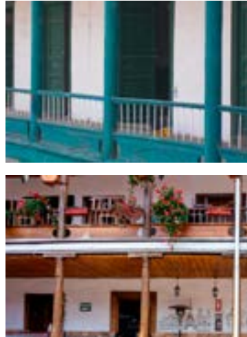
Fig. 117. Cambio de color. Antes y después de la intervención.
