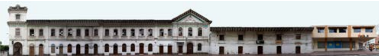
E1_002 FACHADA SIMÓN BOLIVAR - CARDOSO 2011
