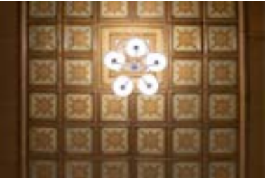
Fig. 90. Cielo raso de latón en salón principal.
