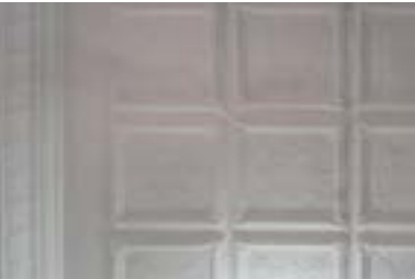
Fig. 91. Cielo raso de estuco de yeso con molduras en crujía frontal, planta alta.
