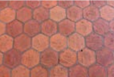
Fig. 95. Piso de ladrillo.
