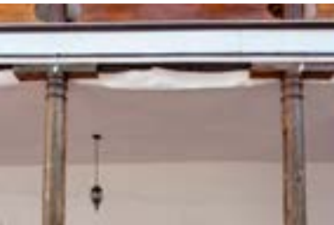
Fig. 93. Cielo raso de barro.
