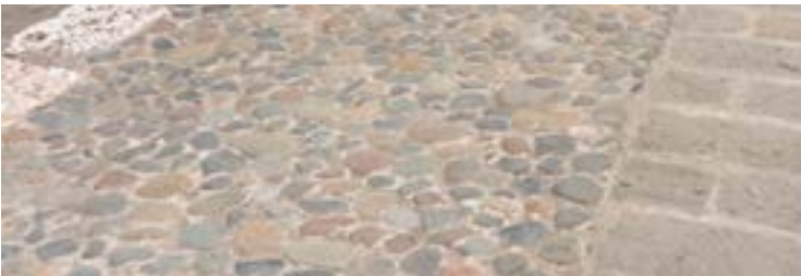
Fig. 98. Piso de piedra.
