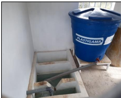
Imagen 7. Tanque de cloración realizada al goteo.
