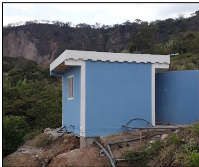
Imagen 6. Cuarto de cloración.
