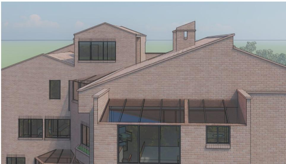
Por un lado, en la torre de vivienda las cubiertas son parte fundamental de la forma de la edificación, las cubiertas están dispuestas con una pendiente del 36% o 20°. En lo que se refiere a la materialidad de las cubiertas pueden ser de teja artesanal sobre planchas onduladas de fibrocemento o cubiertas de vidrio sobre una estructura metálica.
