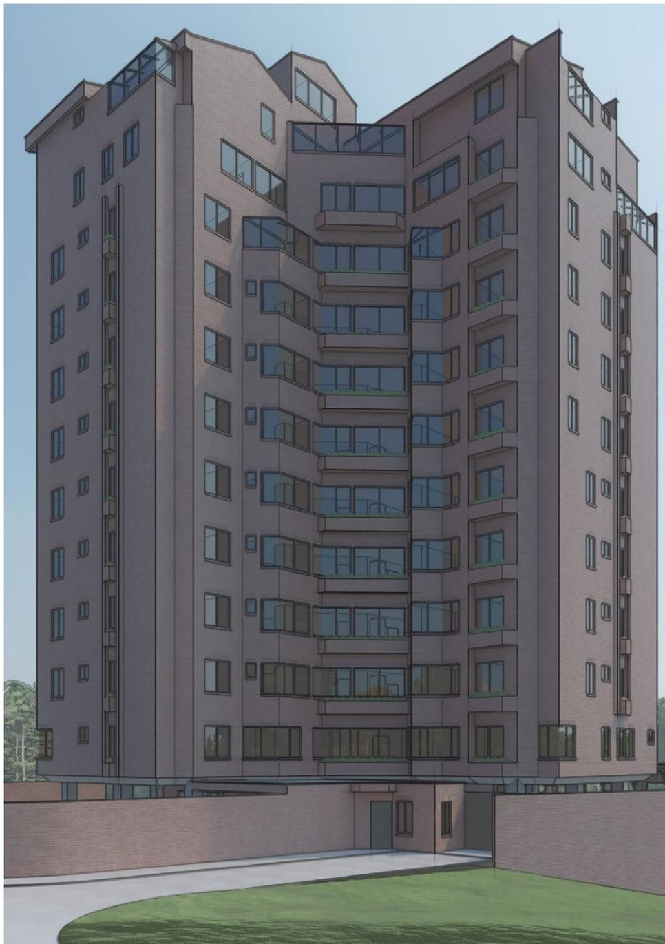
A los costados de algunas ventanas se colocan volúmenes prominentes de ladrillo a manera de una especie de pilastras para enmarcar una hilera continua de ventanas.
