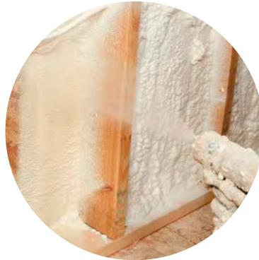
Figura 72\_ Aplicación de espuma de poliuretano
