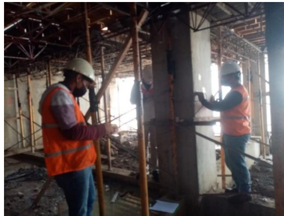
Figura 28: Ensayo de ultrasonido en obra
