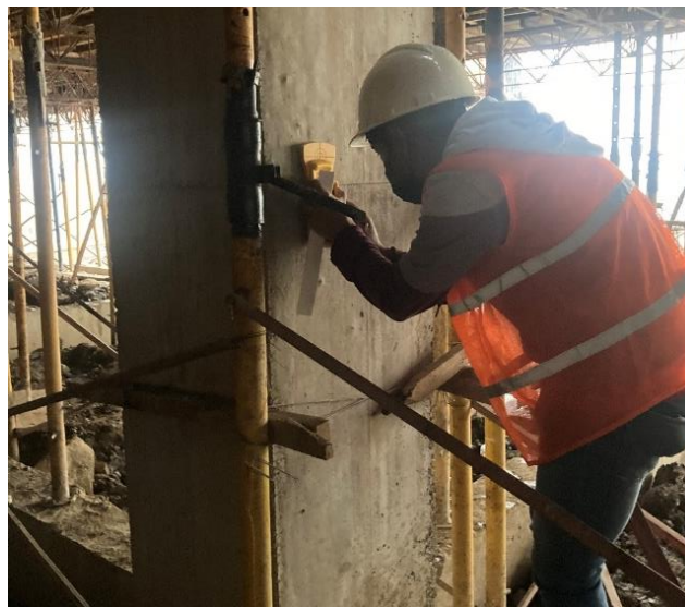
Figura 26: Ensayo de detección de armaduras
