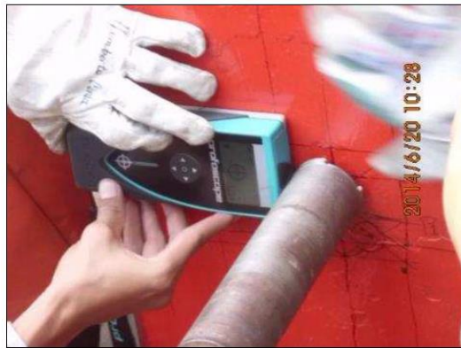
Figura 6: Ensayo de detección de armaduras
