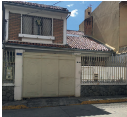
Figura 26: Fachada de la vivienda Realizado por: Gabriela Sinchi (2020)
