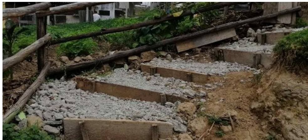
Imagen 18: Actora de mejora- construcción de gradas en un sendero peatonal. Fuente y Elaboración: Marín & Ruilova. (2022)
