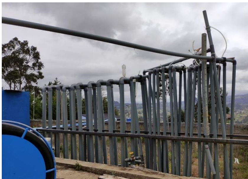
Ilustración 10 Entrada floculador vertical diámetro 110mm y 63 mm
