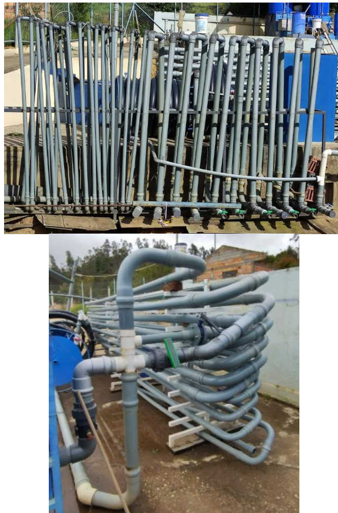
Ilustración 6 Sistema piloto de geometría vertical y horizontal respectivamente armados en la PTAP Bayas
