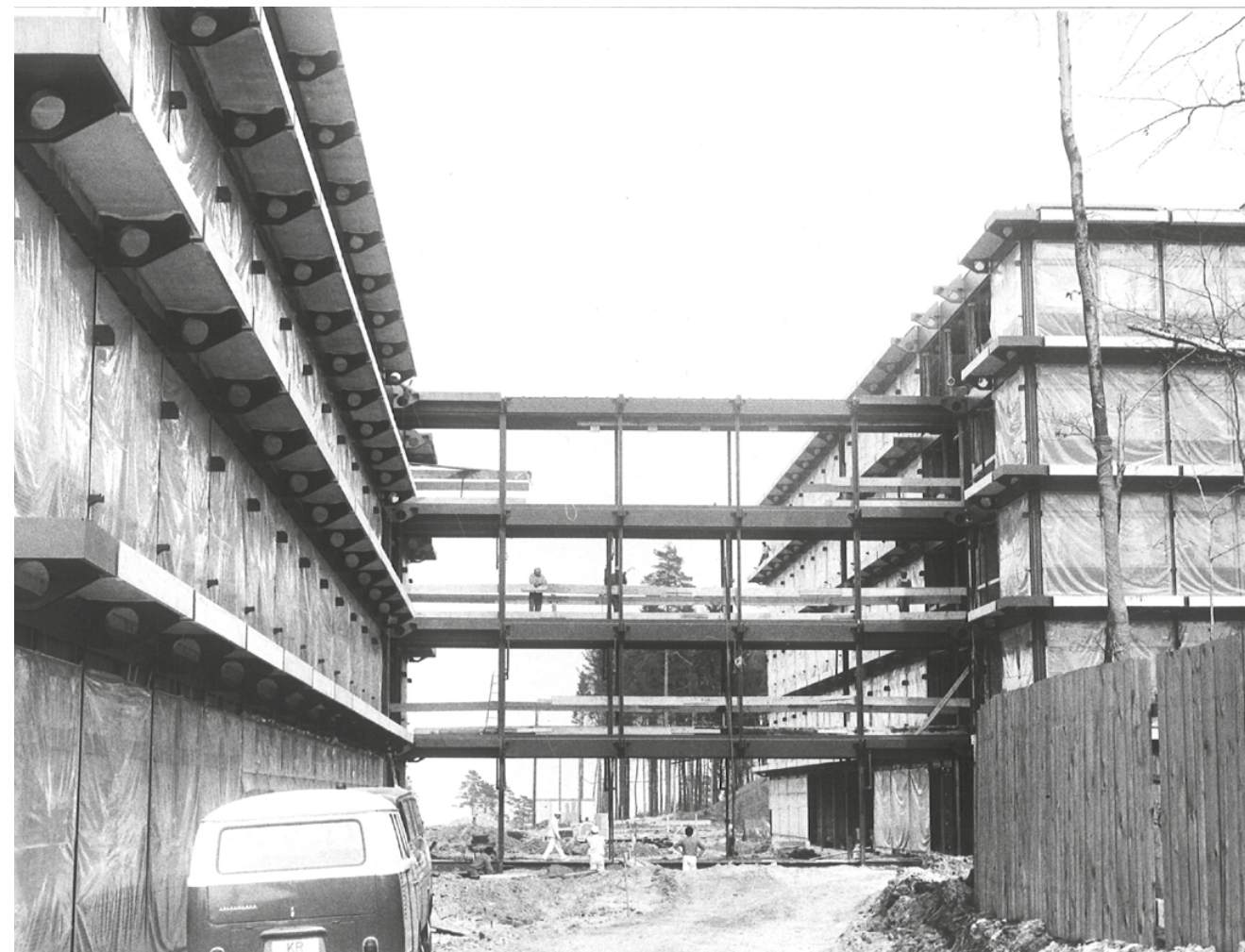
108. IBM en proceso de construcción. En los pabellones se observa únicamente la ausencia de lamas automatizadas, tubos verticales y horizontales. Al centro la pasarela sin carpintería y pasillos exteriores (saai).
