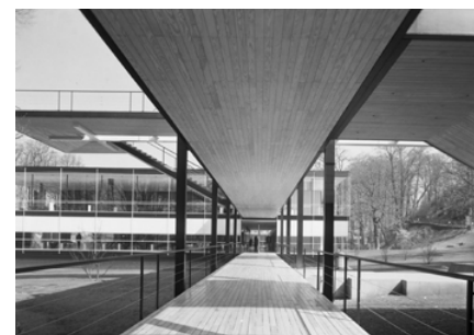
66. Pasarela de conexión, vista hacia pabellón 8. 67. Cubierta de pasarela y puerta pivotante abierta. 68. Vista desde pasarela hacia Pabellón 1. 69. Pasarela de conexión entre Pabellón 1 y Pabellón 8.
