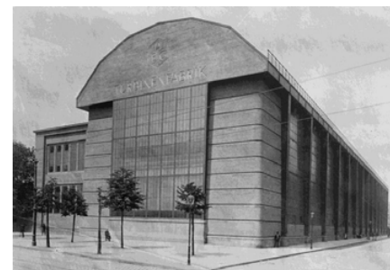
03. Fábrica de turbinas de la A.E.G, Berlín, 1909. 04. Fábrica de turbinas de la A.E.G vista interior.
