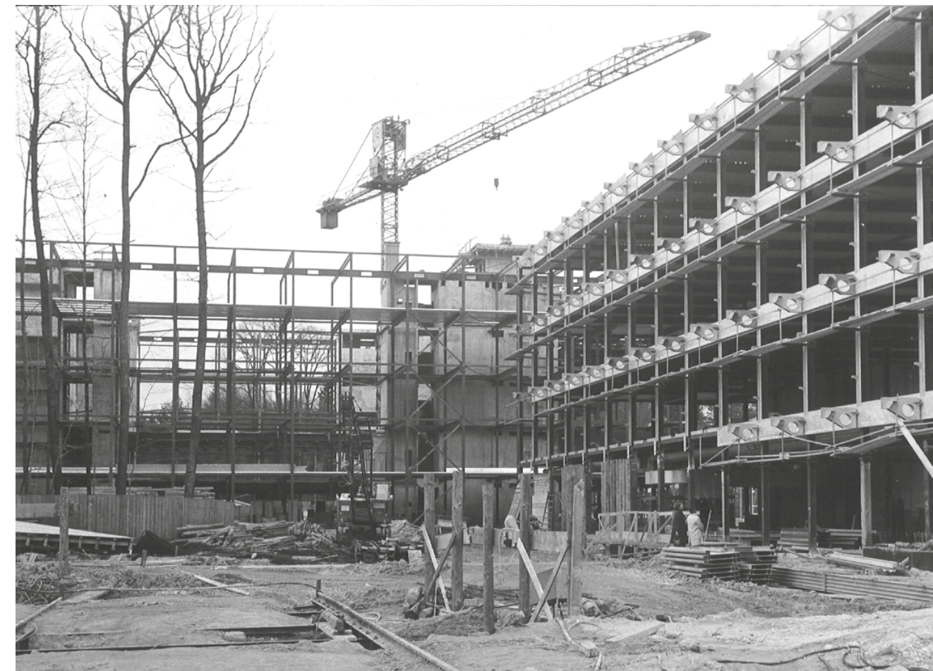
106. IBM en etapa de construcción, en primer plano Pabellón I, hacia atrás con la grúa el Pabellón II, a la derecha en las consolas y en las columnas se soportan sistemas provisionales de andamiaje(saa).
