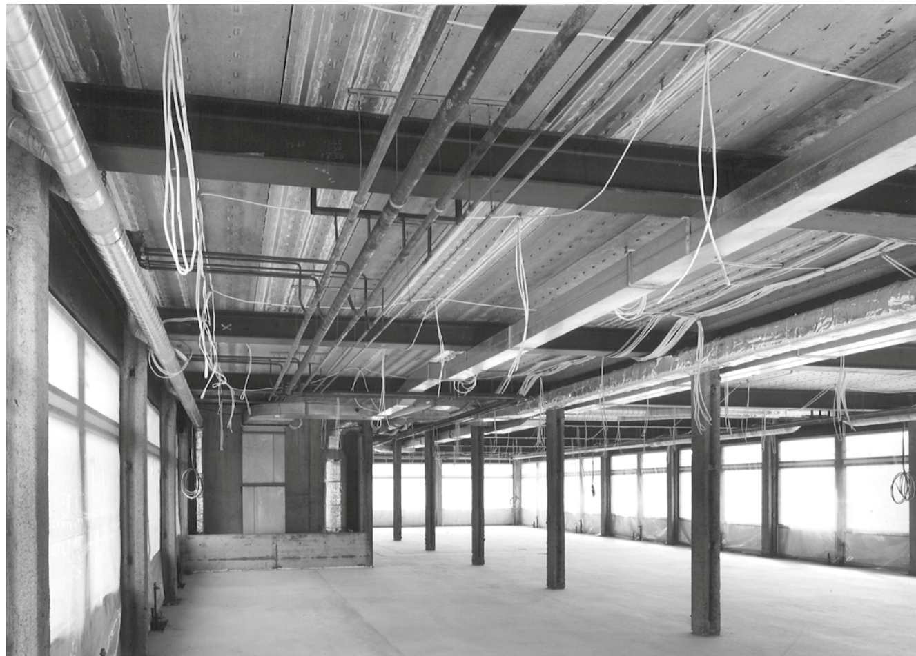
128. Interior en etapa de construcción. En la parte superior, las placas perfiladas sobre las vigas de acero, y debajo la cantidad de redes de instalaciones. Las columnas forradas de amianto pulverizado.
