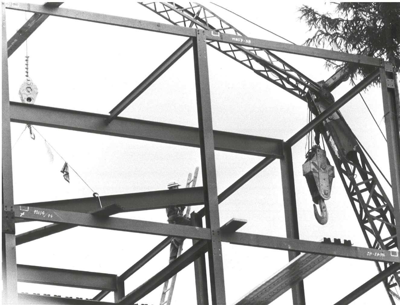
107. Ensamblaje de la estructura de acero, en la imagen se pueden identificar los diferentes elementos estructurales (columnas tipo H, vigas tipo "I" y tipo "C", unidos mediante pernos) y su codificación (saai)
