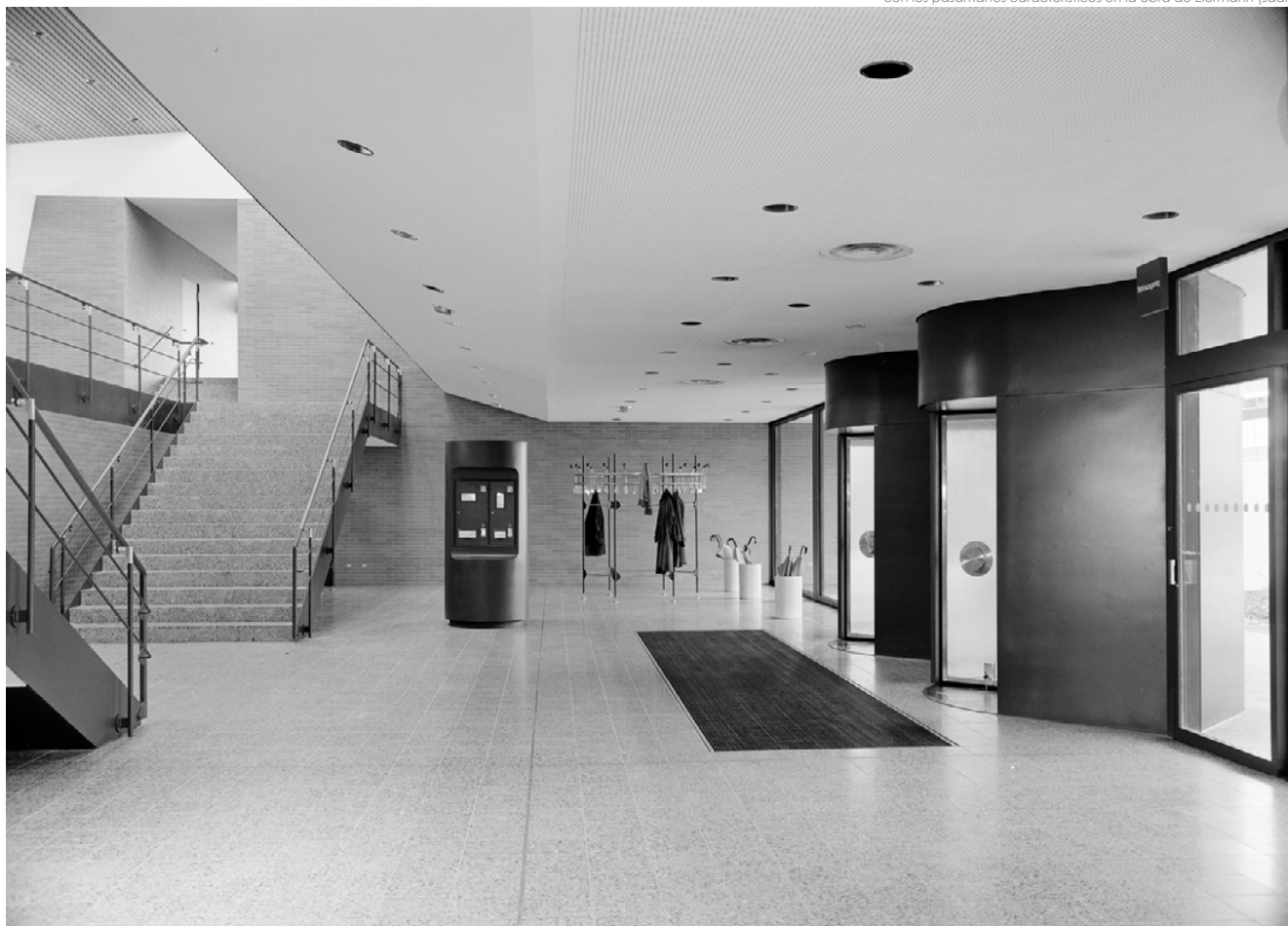
104. Imagen histórica, vestíbulo del bloque de cafetería. A la derecha la doble puerta de acceso, a la izquierda las dos escaleras con los pasamanos característicos en la obra de Eiermann (saai).
