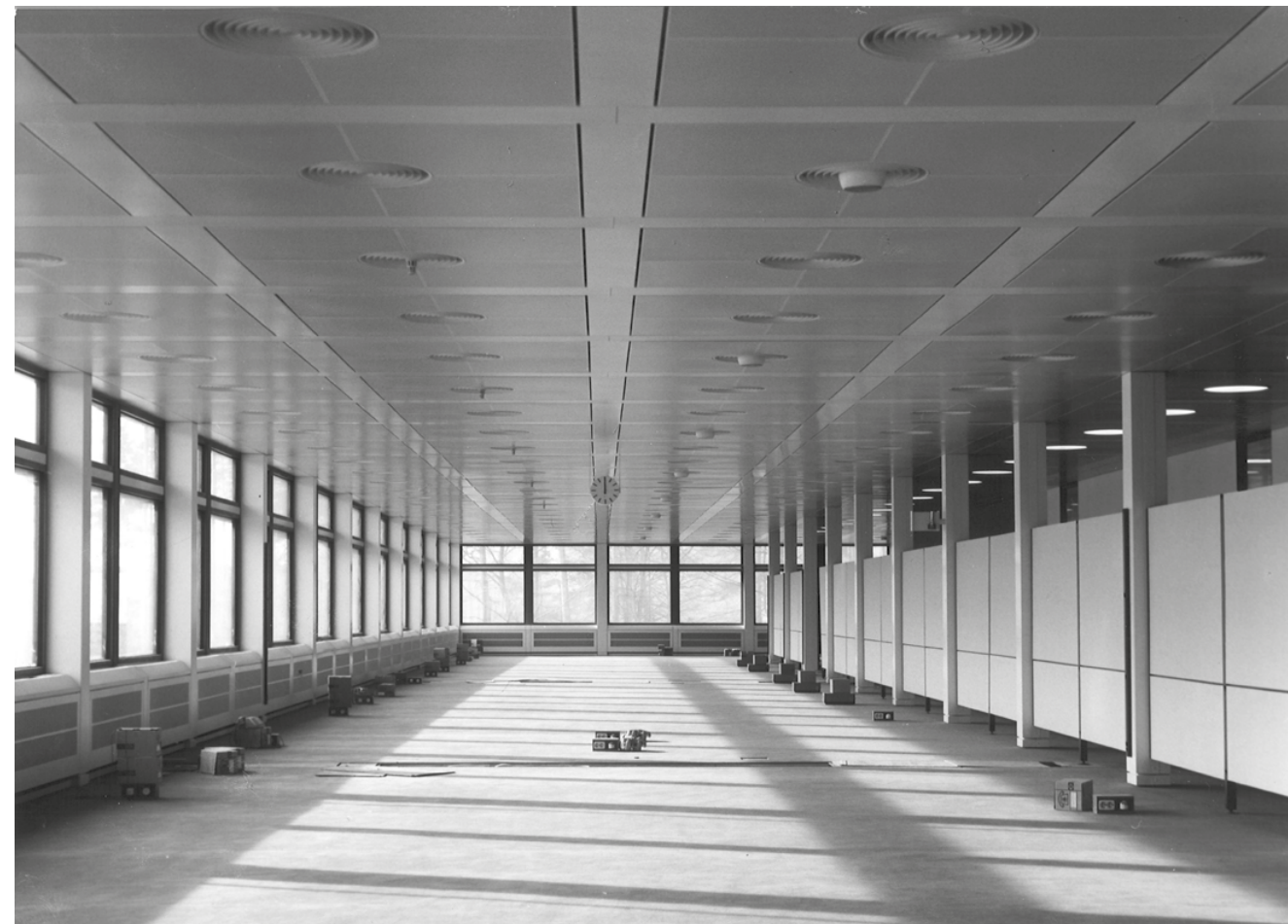
129. Interior en etapa de construcción, espacio para oficinas grandes, a la derecha las ventanas con los paneles de aire acondicionado, a la derecha los paneles móviles, en la parte superior el cielo raso desmontable con los apliques necesarios.
