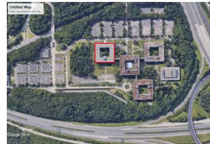
92. Vista aérea, google earth, ampliación de un bloque de oficinas al este. 93. Estado de deterioro de los toldos de la cafetería. 94. Desgaste y corrosión de los elementos de fachada.
