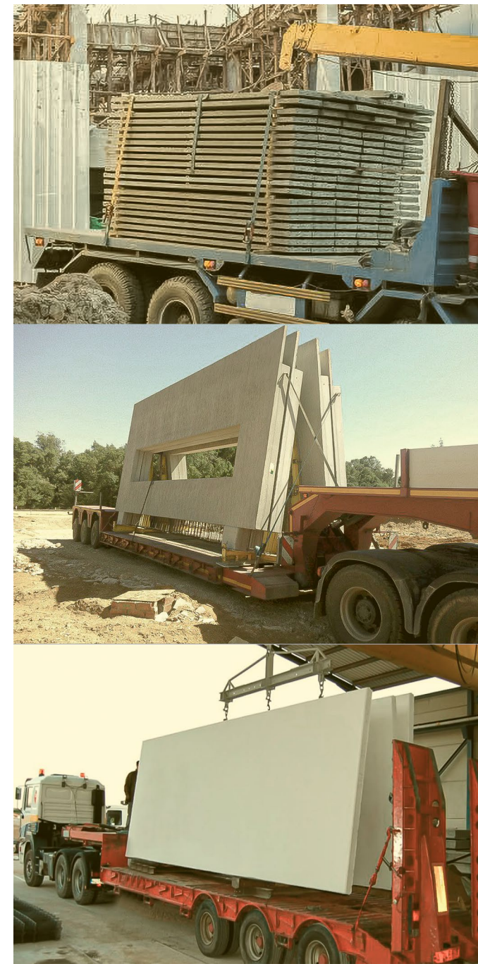
Imagen 25: Transporte del hormigón prefabricado a la obra Fuente: Google
