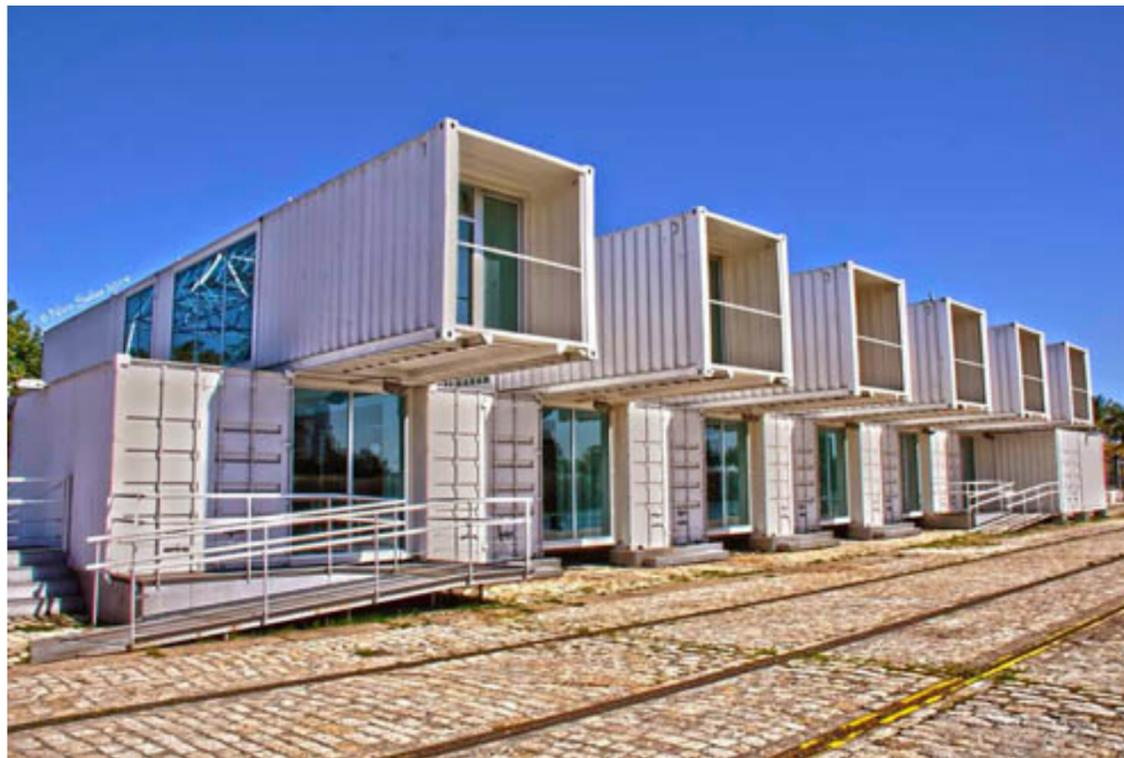
**Estructuras desmontables.** Se considera a las estructuras atornilladas o soldadas como los contenedores metálicos por ser módulos prefabricados.
