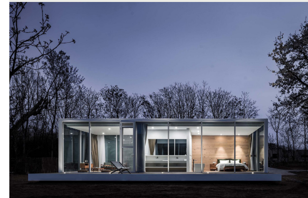
Figura 313: Vista Exterior Nocturna. Fotografía: WU (2019)
