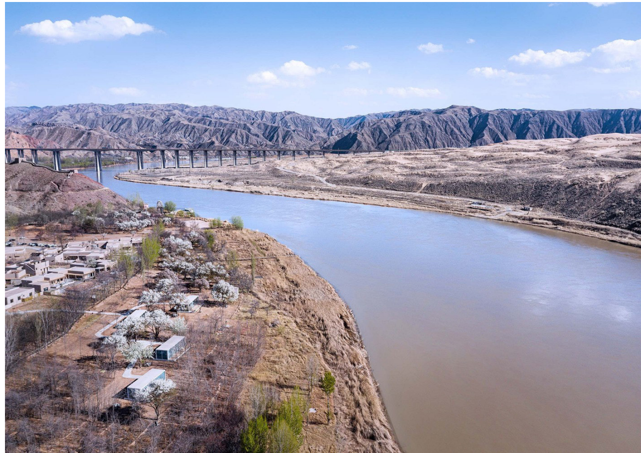
Figura 312: Vista Exterior Conjunta. Fotografía: WU (2019)
