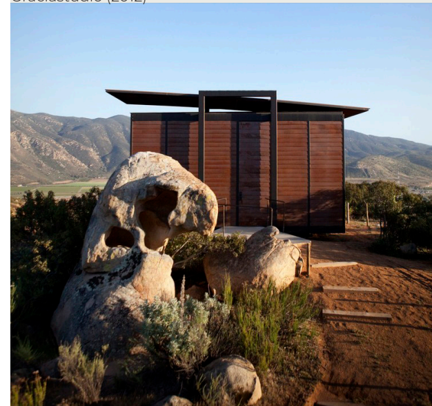
Figura 237: Vista Exterior. Fotografía: García (2012)
