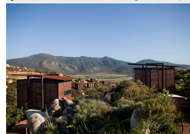
Figura 241: Vista Externa. Fotografía: García (2012)
