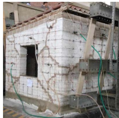
d) Ambiente de adobe reparado y reforzado
