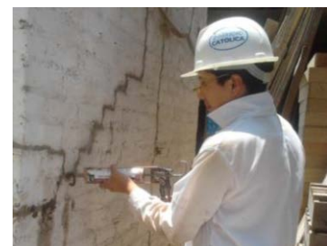
c) Inyección de barro líquido
