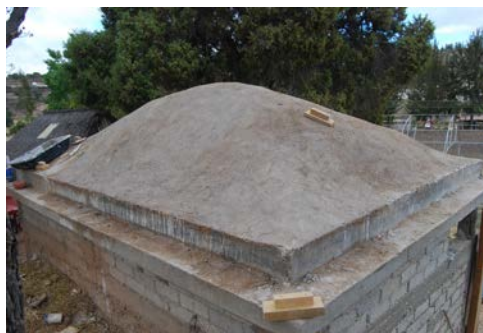
Figura 5. Acabado final con un revoque de cal y arena. (Foto: L. Guerrero, 2015).
