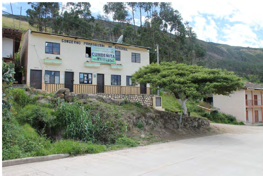
Figura 3. Edificación perteneciente al GAD Parroquial de Susudel. (crédito: F.Cardoso, 2013)
