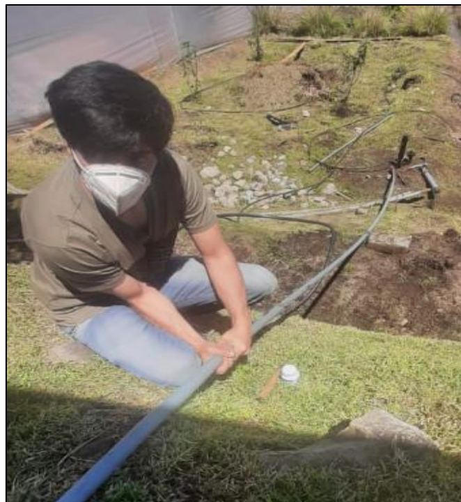
Anexo 2: Instalación de la tubería de descarga
