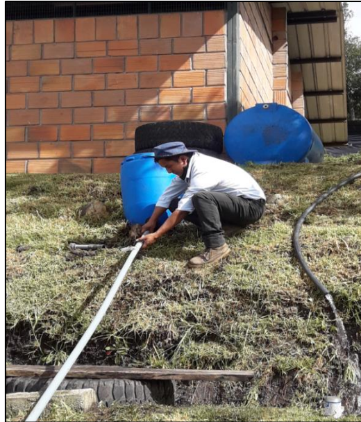
Anexo 2: Instalación de la tubería de descarga
