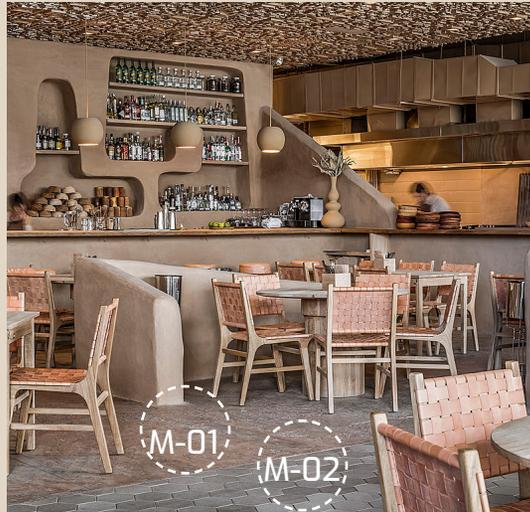
Con el fin de transportarnos a épocas prehispánicas se trabajó con muros bajos, variando su altura, dando la idea que los muros nacieron de la misma tierra y han sido erosionados, por esto es que fueron realizados con aplanados de tierra.
