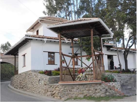
Fig 59. Restauración de la casa Jesús de Arriaga. Fuente: Diario el Mercurio, 2018. Recuperado de: https://ww2.elmercurio.com.ec/2018/07/21/el-28-de-julio-abre-casa-del-artista/
