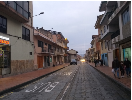
Fig 111. Vista hacia la casa Malo Valdivieso sobre el eje de la calle Antonio Vega Muñoz, centro histórico de Cuenca. Fuente: Propia, 2020.
