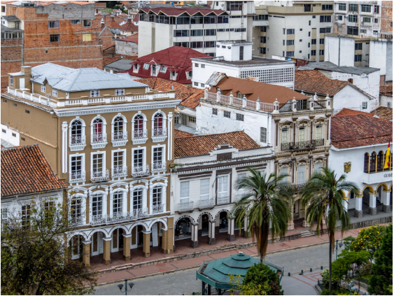
Fig 57. Edificaciones del centro histórico de Cuenca . Fuente: Proporti, s.f. Recuperado de: https://www.properati.com.ec/guia-de-ciudades/cuenca
