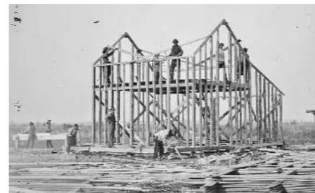
Fig.26. Sistema Balloon Frame 1832. Sistema de construcción en madera, característico de USA, conformada por listones finos de madera como estructura, manejables y de fácil construcción.
