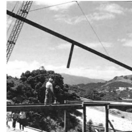
Fig. 100- Montaje prefabricado de la estructura metálica por medio de una grúa en sitio. La facilidad del armado por medio de ensambles repetitivos, facilita su proceso de construcción. Fotografía publicada en perfil de instagram Case Study House 26.
