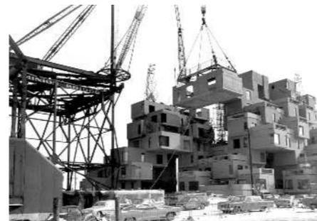
Fig.66.- Ensamble de módulos compositivos. Unidades habitacionales prefabricadas, facilitan el ensamblaje in situ por medio de grúas industriales.
