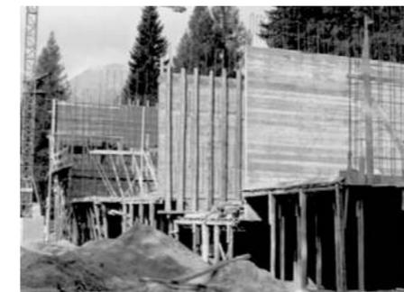
Fig. 158- Encofrados en proceso de obra para el colado del hormigón, muestra la posibilidad de trabajo progresivo de varios módulos.
