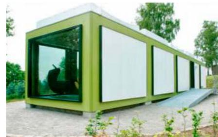
Fig.61.- Prototipo del modelo Kubeflex, traslado a su nueva ubicación. Muestra los paneles laterales fijos y la mampara de iluminación, ambos están coordinados modularmente.
