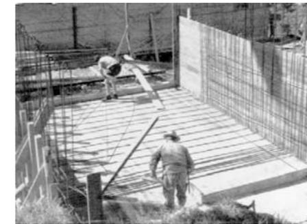
Fig. 157- Ejecución en obra del módulo prismático estructural en hormigón armado.
