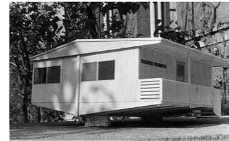
Fig.55.- Prototipo residencial Casa Plas 2 points. Evidencia cimentación mínima utilizada y su estructura en voladizo para piso y cubierta donde el principio estructural refleja su condición.
