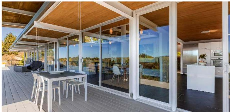
Fig. 107.- Imagen que muestra mamparas de Vidrio con estructura de aluminio en blanco. material con transparencia, que permite la vinculación interior - exterior, y la iluminación natural de todos los ambientes.
