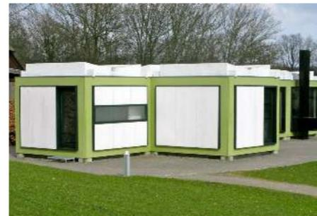
Fig.62.- Vista del prototipo donde se evidencia la agrupación de módulos prefabricados ensamblados en sitio, y los elementos de envoltorios interiores.
