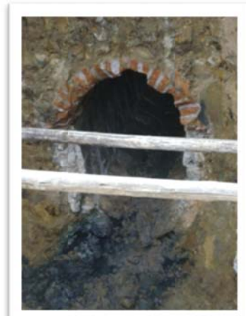
Fotografía 12: Boca del Colector.
