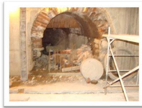
Fotografía 2: boca del Colector.
