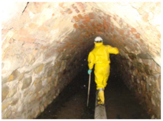
Fotografía 8: El Colector presenta el cambio de arco de medio punto por un arco ojival.
