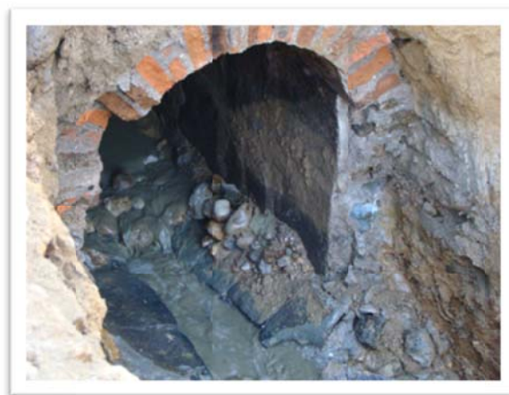
Fotografía 13: Boca de Colector.
