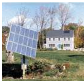
Figura 2-15: Colocación de un grupo de paneles sobre un poste.
