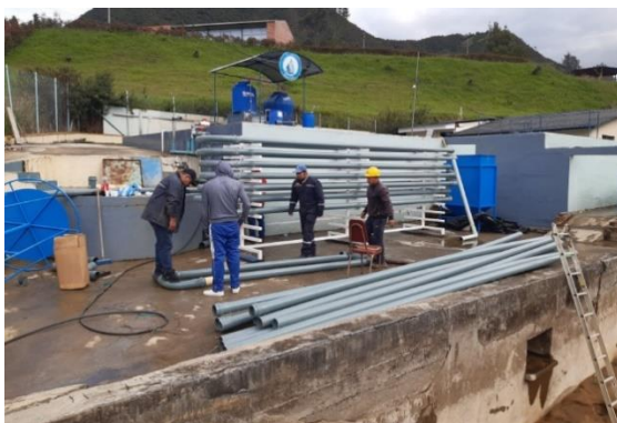
Figura 37: Construcción del FTH piloto. Fuente: Méndez & Trelles (2021).
