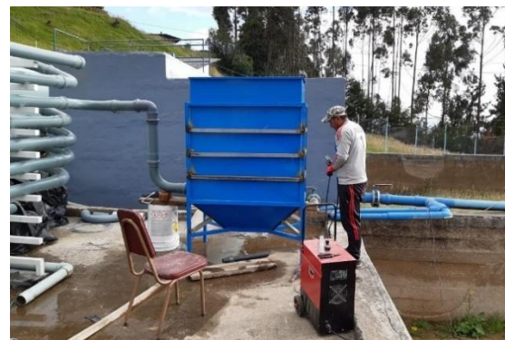
Figura 38: Construcción del sedimentador piloto. Fuente: Méndez & Trelles (2021).
