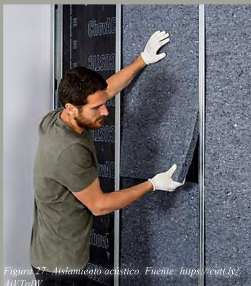
Figura 27: Aislamiento acústico. Fuente: <https://cutt.ly/AiVTrdW>
