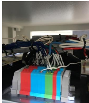
Fig. 3. 25. Bornes de líneas de comunicación.
