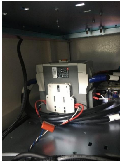
Fig. 3. 23. Contactor de suministro de potencia en AC.
