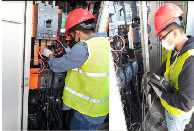
Figura 3.6. Medición en el tablero principal del transformador de 500 kVA (Elaboración Propia).
