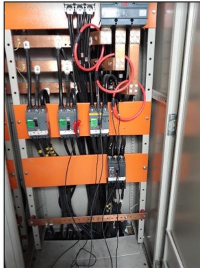
Figura 3.5. Medición en el tablero principal del transformador de 350 kVA (Elaboración Propia).
