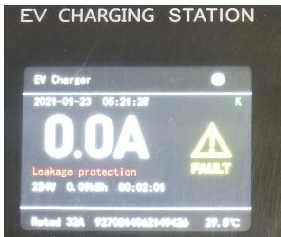
Figura 4.24 Estado de Error en la EVSE, Protección Contra Fugas de Corriente
