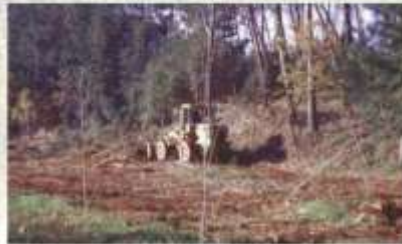
Imagen 1. Desbroce y limpieza para la construcción de un Sistema de humedales construídos Fuente: (García & Corzo, 2008)
