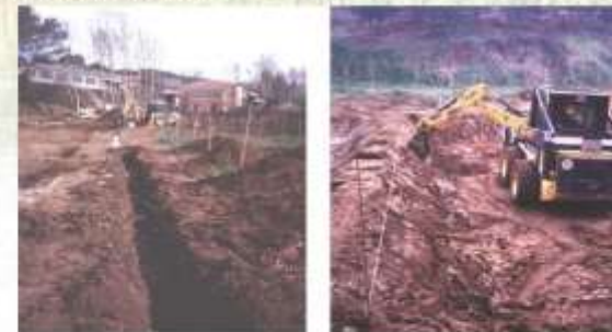
Imagen 2. Excavación para colocación de tuberías y conformación de taludes. Fuente: (García & Corzo, 2008)
