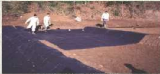
Imagen 5. Colocación de la geomembrana. Fuente: (García & Corzo, 2008)
