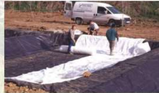
Imagen 6. Colocación del geotextil. Fuente: (García & Corzo, 2008)
