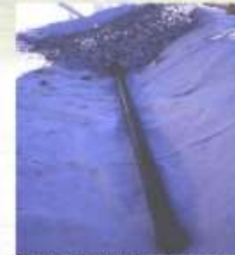
Imagen 4. Instalación de tubería de salida del humedal. Fuente: (García & Corzo, 2008)
