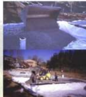
Imagen 7. Colocación del material granular Fuente: (García & Corzo, 2008)
