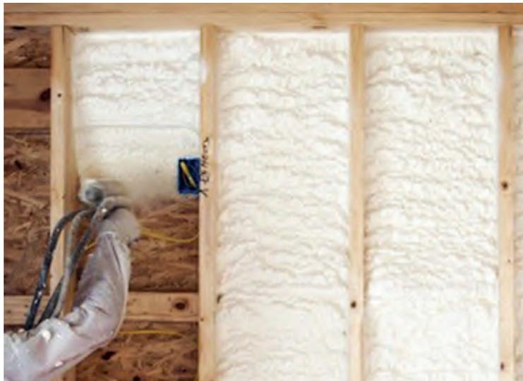
Fotografía 49: Paneles con espuma de poliuretano
