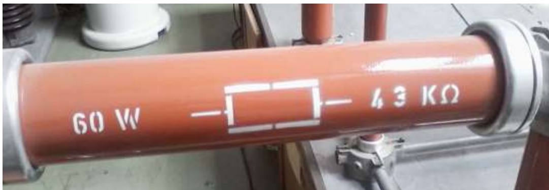
Figura 40 Resistor para alto voltaje
