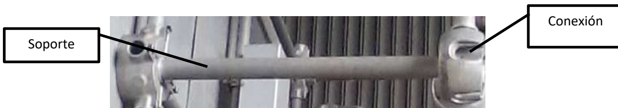
Figura 42 Aislador y uniones
