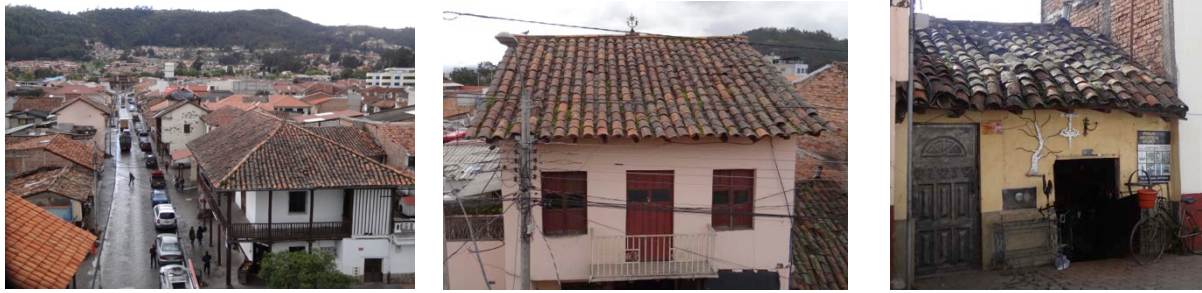
Figura 1. (Izquierda) Vista general de la calle de las Herrerías. Figuras 2 y 3 (derecha). Edificaciones seleccionadas por su valor patrimonial y estado de conservación (Créditos: M. C. Achig)
