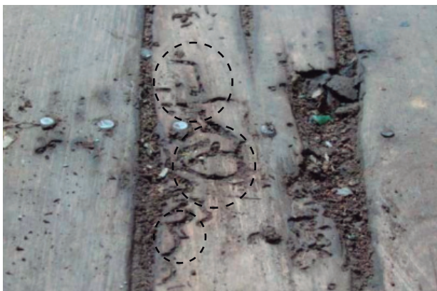
Daño: 2.1.6 Degradación de xilófagos
