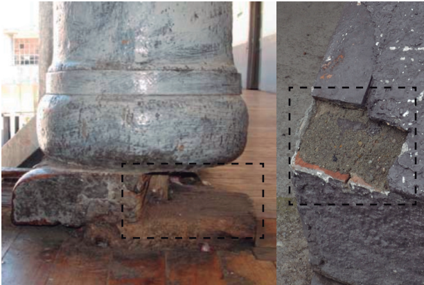
Daño: 2.3.6 Desprendimiento (faltante)
