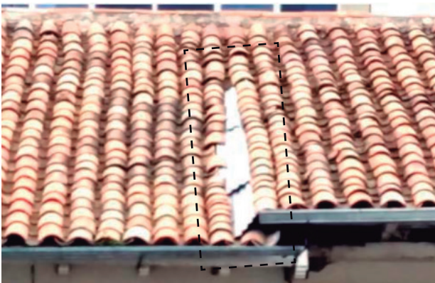
Daño: 4.3 Desplazamiento
