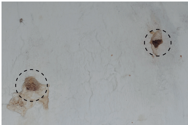
Daño: 2.3.3 Perforación
