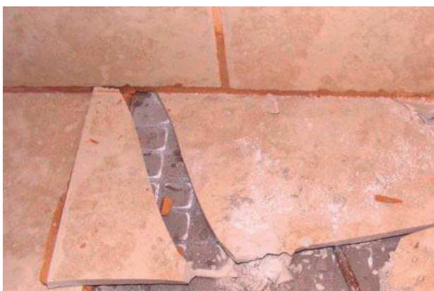
Daño: 2.3.4 Rotura
