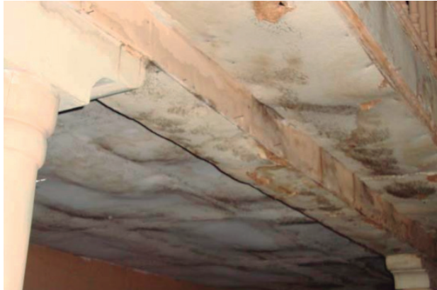
Daño: 2.1.4 Expansión en forma de ampollas
