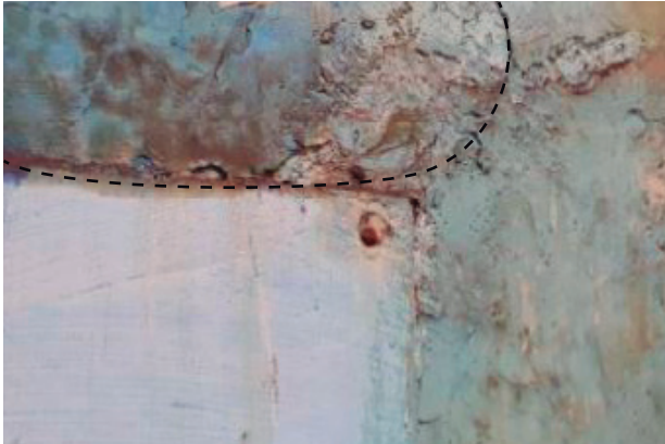
Daño: 4.8 Abombamiento superficial del revoco
