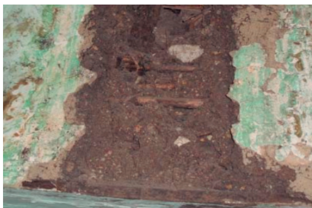
Daño: 2.1.3 Erosión
