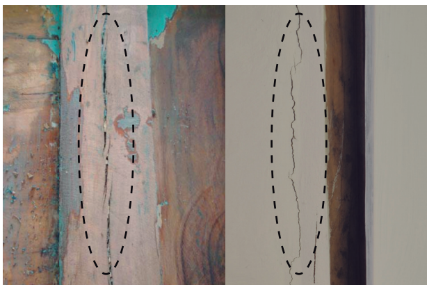
Daño: 3.1 Fisura
